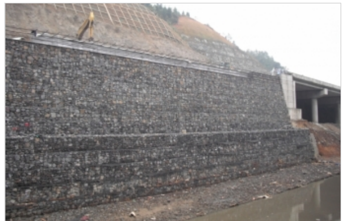
图一：项目施工中
