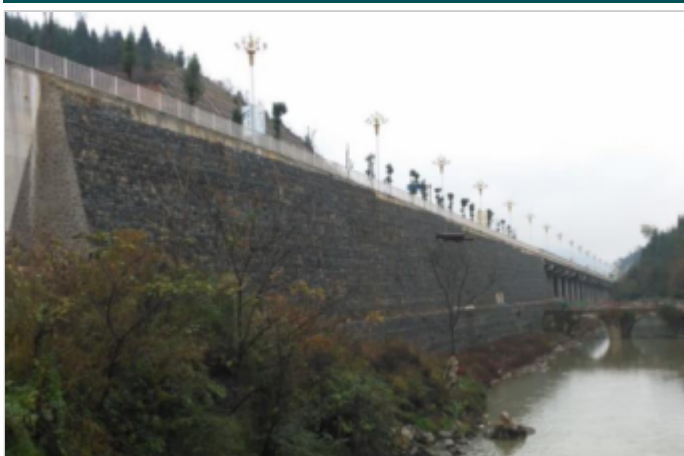
图三：项目竣工照片
