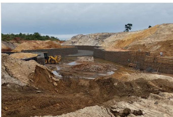
Durante a obra
