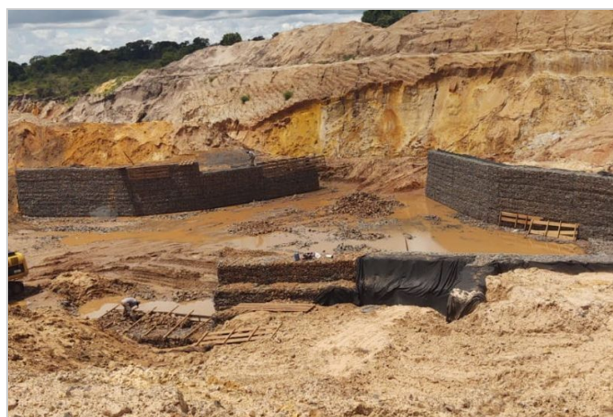
Durante a obra
