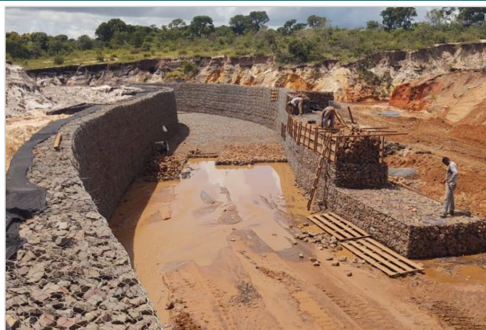
Durante a obra
