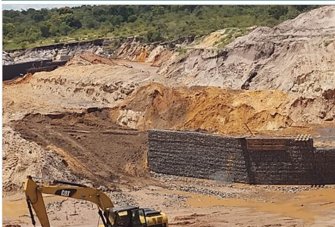
Durante a obra
