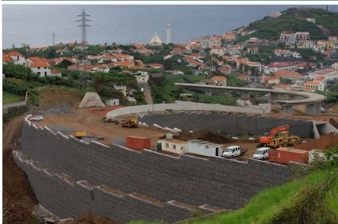
Vista longitudinal del muro simétrico
