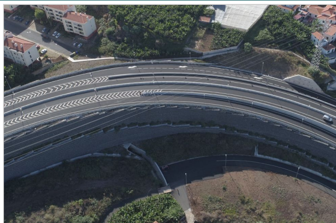
Vista aérea de la infraestructura vial
