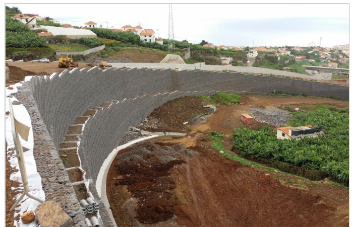
Vista en coronación durante el proceso constructivo
