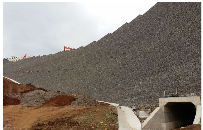
Ejecución del Sistema Terramesh con paso hidráulico
