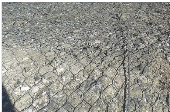
STEELGRID HR-100, μετά τη τοποθέτηση
