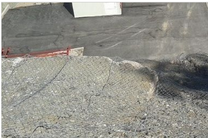
STEELGRID HR-100, μετά τη τοποθέτηση
