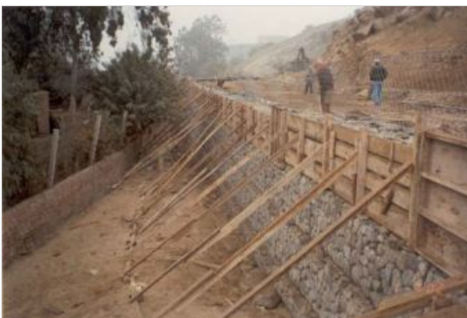
Durante la Obra
