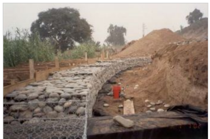
Durante la Obra
