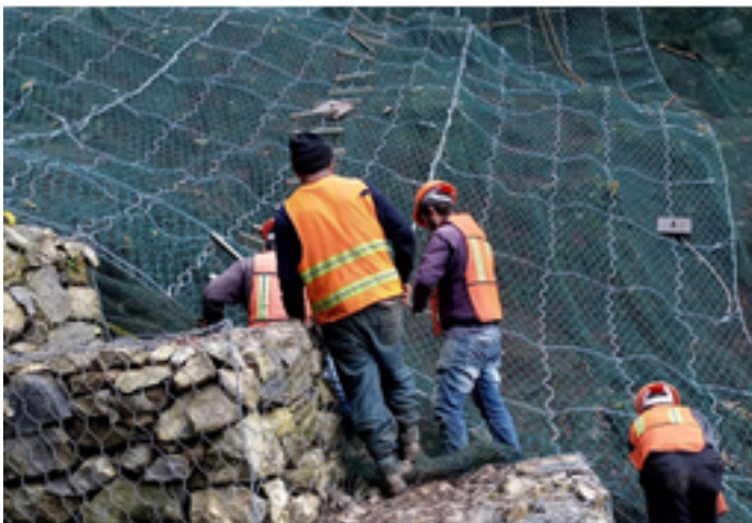
TALUD KM 184 AUTOPISTA MEXICO-TUXPAN, PUE._2
