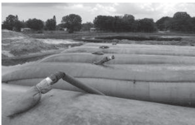
Figura 4.4.8 - Durante la obra
