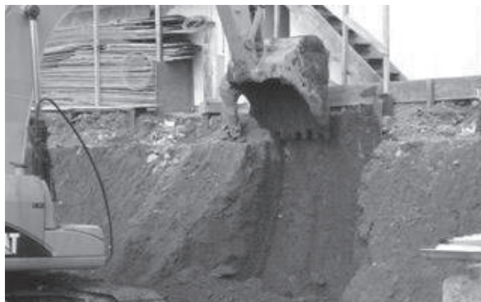
Figura 2.1.11 - Durante la obra
