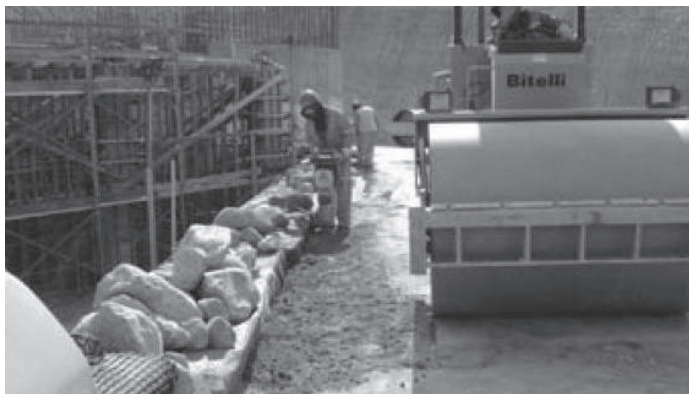
Figura 3.1.86 - Durante la Obra
