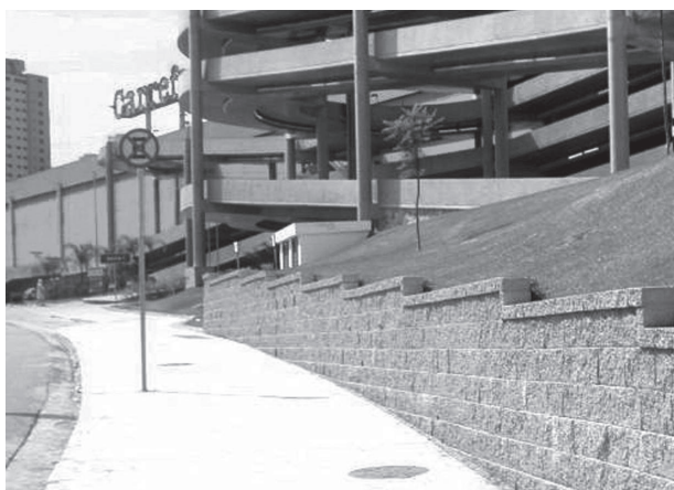
Figura 3.1.9 – Fotos de la aplicación en contención de la solución MacWall®.
