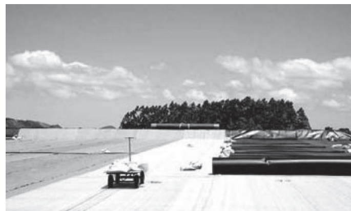
Figura 4.2.16 - Durante la obra
