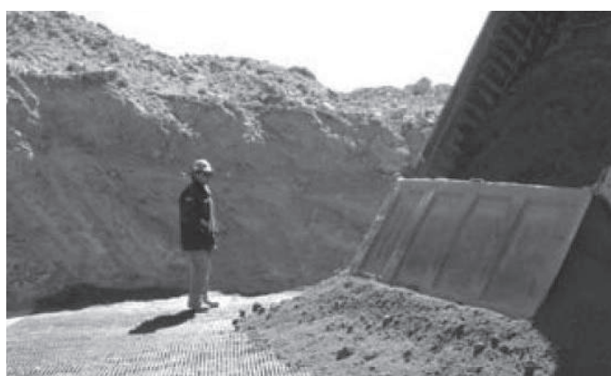
Figura 3.1.85 - Durante la obra
