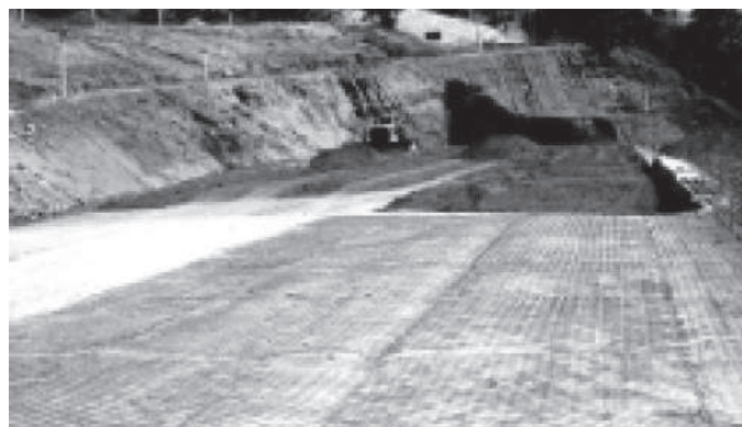
Figura 3.1.58 - Durante la construcción
