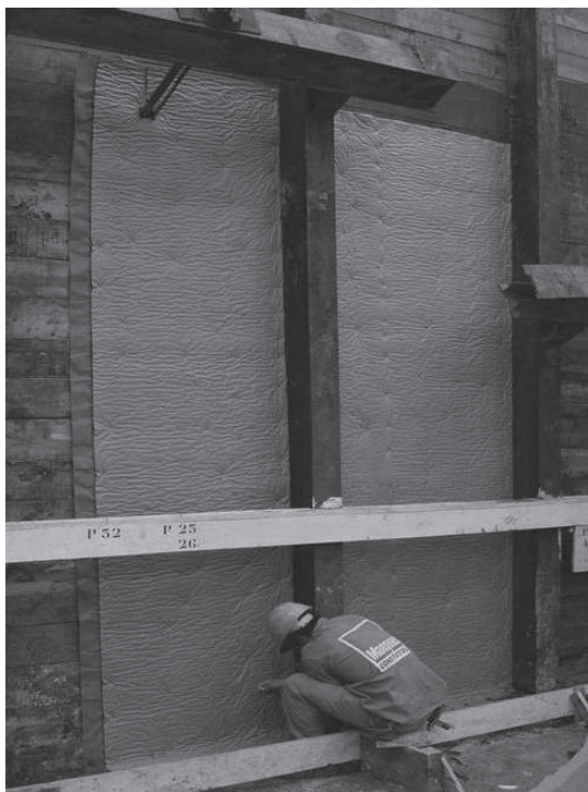
Figura 2.1.1 – Sistema de drenaje vertical con uso del geocompuesto MacDrain®. a) Drenaje Vertical con MacDrain® FP. b) Drenaje Vertical con MacDrain® 2L.
