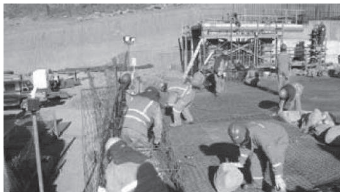
Figura 3.1.81 - Durante la obra
