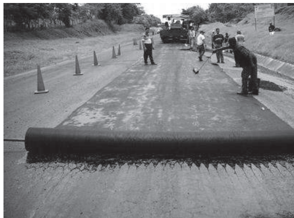
.Figura 1.3.14 - Colocación de geotextil después de ruptura de emulsión asfáltica.
