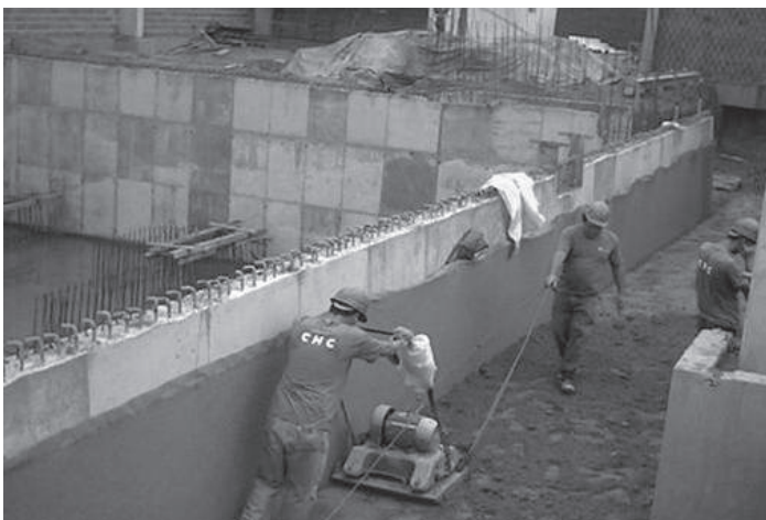
Figura 2.1.26 - Ejecución de terraplén compactado junto al drenaje vertical instalada..
