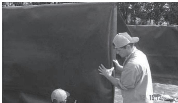
Figura 4.3.9 - Durante la obra
