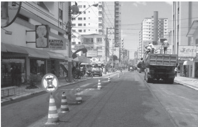
Figura 1.3.9 - Durante la obra
