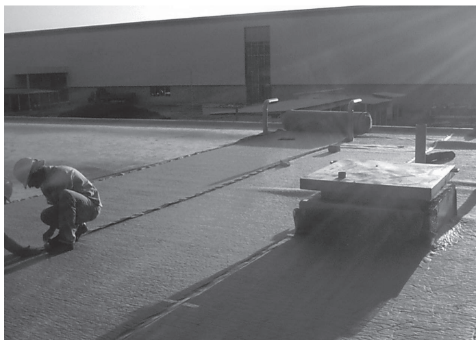
Figura 2.1.25 - Detalle de enmienda entre rollos de geocompuesto drenante en aplicación horizontal.
