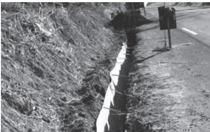
Figura 1.4.12 - Durante la obra
