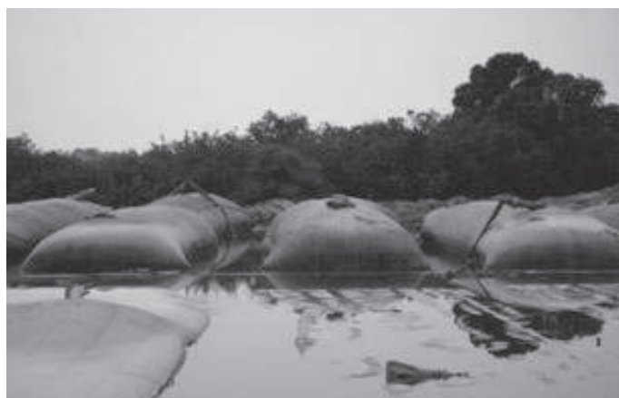
Figura 4.4.9 - Durante la obra
