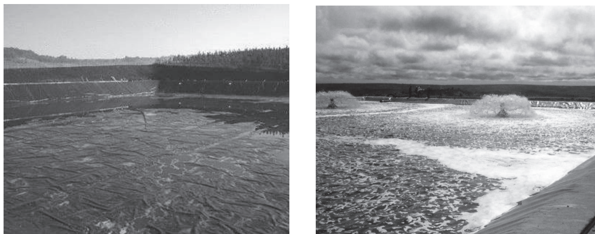
Figura 4.1.2 – a) Laguna de tratamiento después de la instalación de la barrera impermeabilizante; b) laguna de tratamiento en operación.
