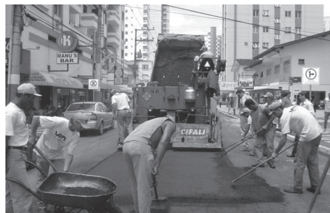
Figura 1.3.7 - Durante la obra
