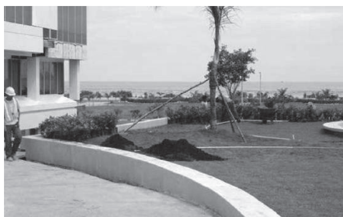
Figura 2.1.22 - Durante la obra
