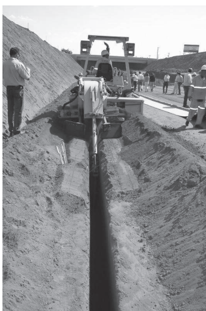
Figura 1.4.14 - Excavación de trinchera con anchura suficiente para colocación de tubo perforado.
