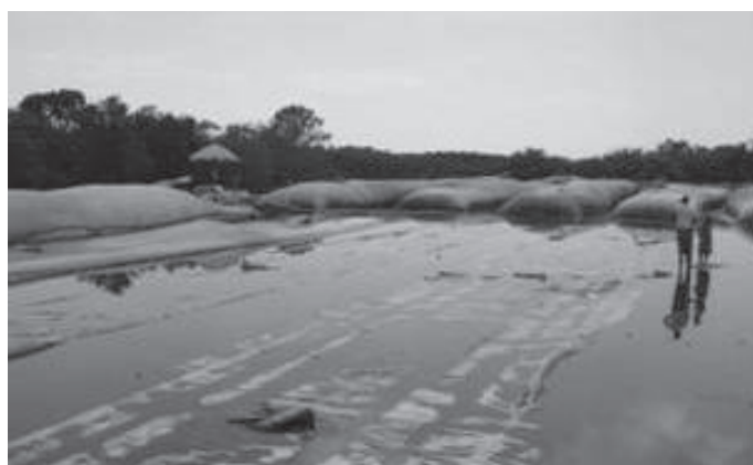
Figura 4.4.11 - Durante la obra
