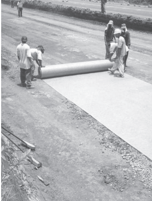
Figura 1.1.13 - Desenrollando el geotextil sobre superficie regularizada.
