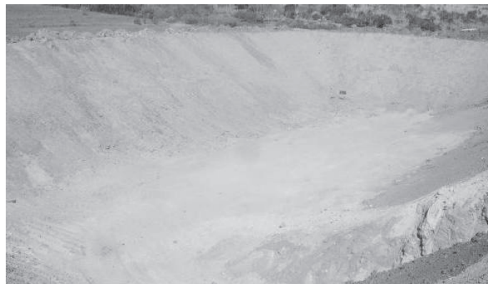
Figura 4.1.8 - Durante la obra
