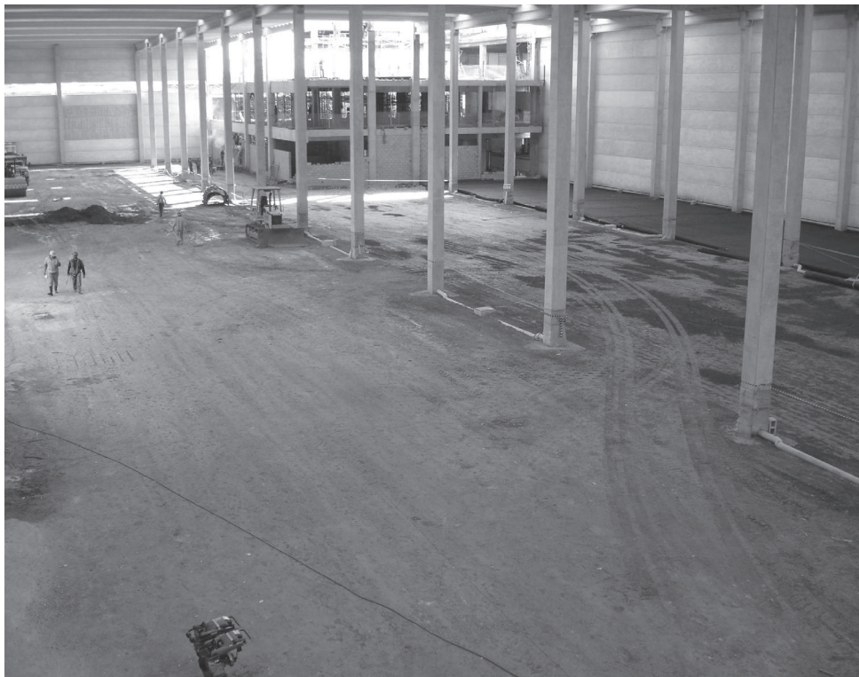
Figura 1.2.14 - Regularización y limpieza del área a ser reforzada.
