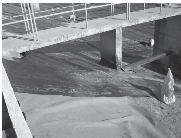
Figura 4.3.1 – a) Fotografía de una laguna de tratamiento con geotextil en espera por la camada de geomembrana; b) geomembrana instalada sobre geotextil no tejido..
