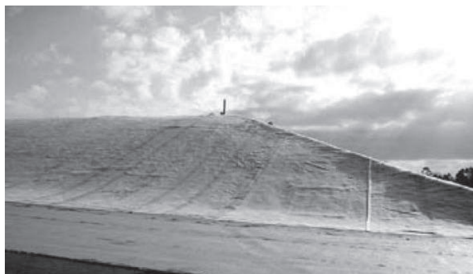
Figura 4.2.11 - Durante la obra
