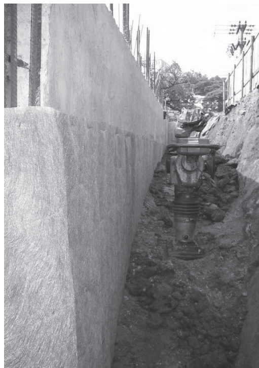
Figura 2.1.1 – Sistema de drenaje vertical con uso del geocompuesto MacDrain®. a) Drenaje Vertical con MacDrain® FP. b) Drenaje Vertical con MacDrain® 2L.
