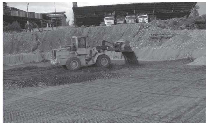
Figura 2.2.15 Aplicación de la camada de suelo y posterior compactación.
