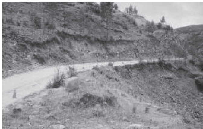
Figura 3.1.50 - Antes de la obra
