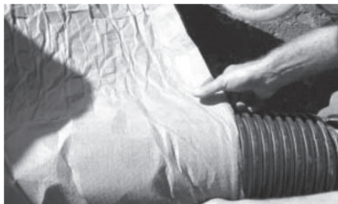
Figura 1.4.8 - Durante la obra
