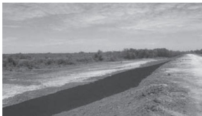
Figura 5.1.23 - Durante la construcción
