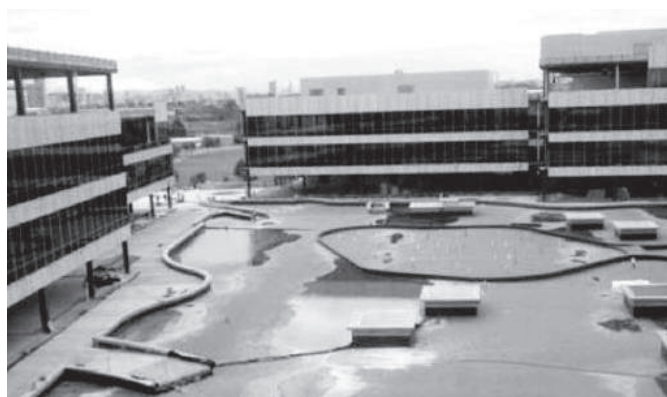
Figura 2.1.17 - Antes de la obra
