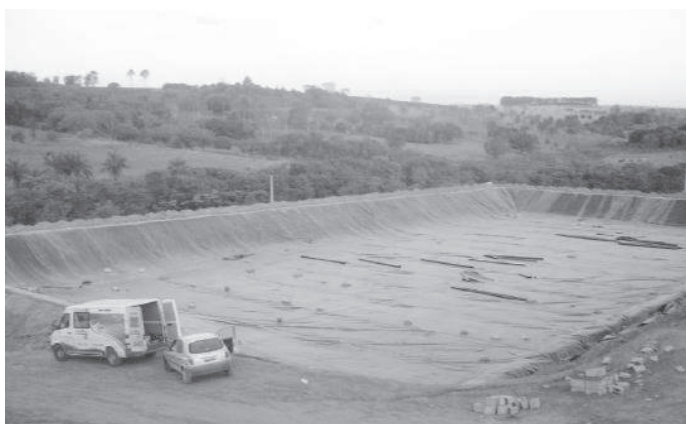
Figura 4.1.13 - Durante la obra
