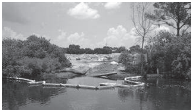
Figura 4.4.6 - Durante la obra
