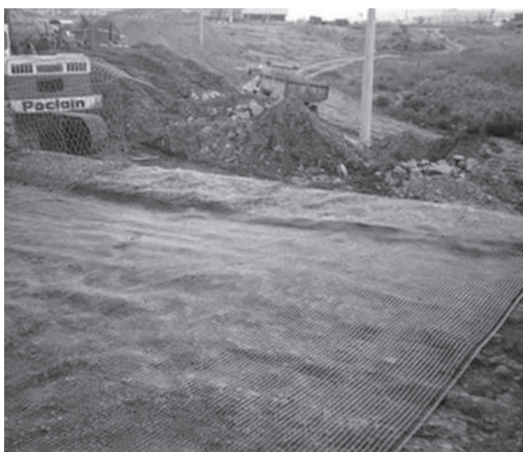
Figura 3.1.89 Aplicación de geogrilla en instalación de solución Terramesh® Grid.
