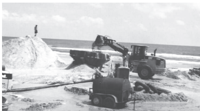
Figura 4.4.13 – Camión rellena el “hopper” con el material seleccionado y la draga bombeando agua a través de un tubo.
