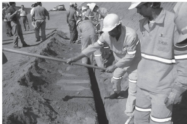
Figura 1.4.17 - Rellenamiento de la trinchera con el mismo material excavado.
