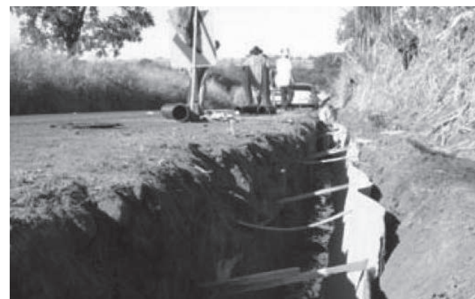
Figura 1.4.13 - Durante la obra
