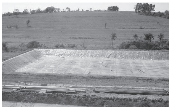
Figura 4.1.12 - Durante la obra
