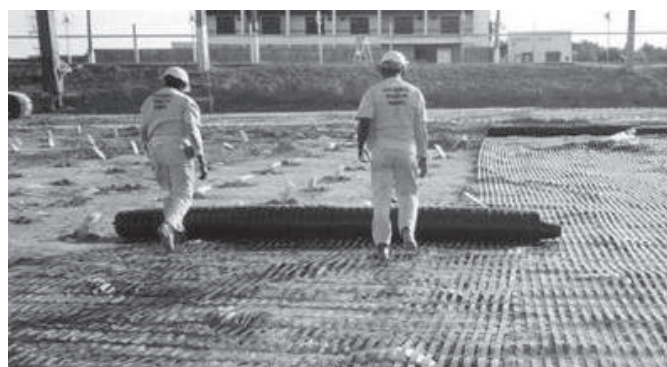
Figura 3.2.8 - Durante la obra
