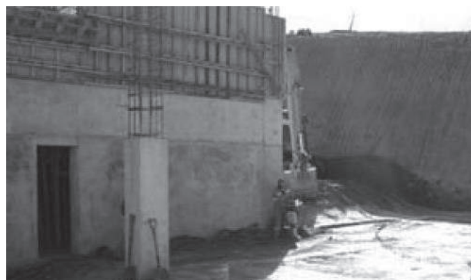
Figura 3.1.80 - Durante la obra
