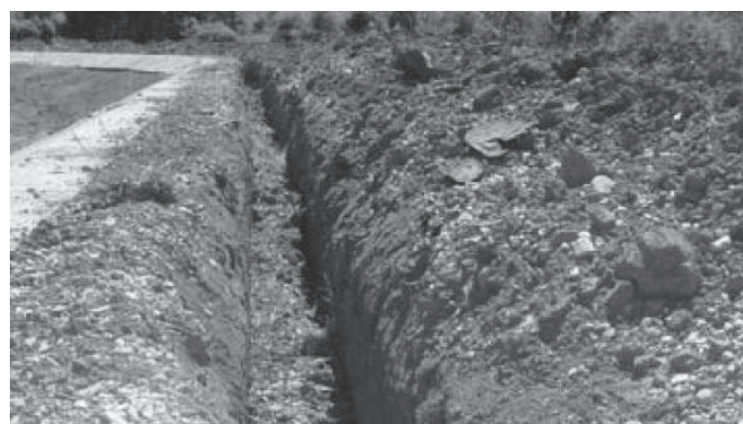
Figura 4.3.4 - Durante la obra
