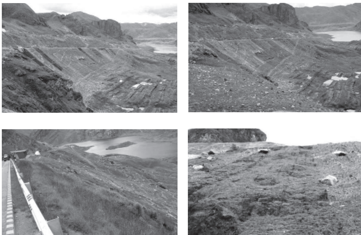
Figura 5.1.19 a 5.1.22 - Después de la construcción
