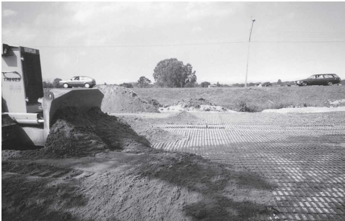
Figura 3.2.13 Avance del material de terraplén sobre la geogrilla.
