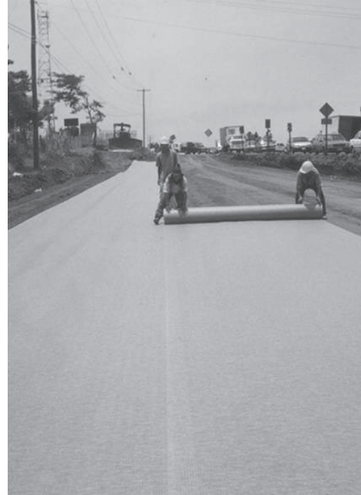
Figura 1.1.14 - Aplicación de segundo rollo con realización de translope.
