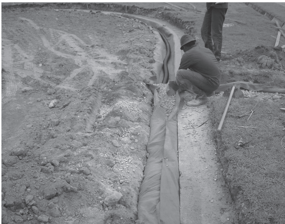
Figura 3.1.90 Preparación de "cuna" y drenaje con grava y geotextil.
