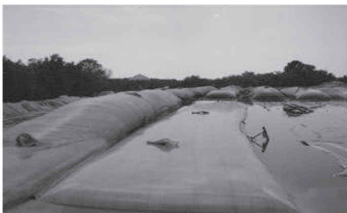
Figura 4.4.10 - Durante la obra
