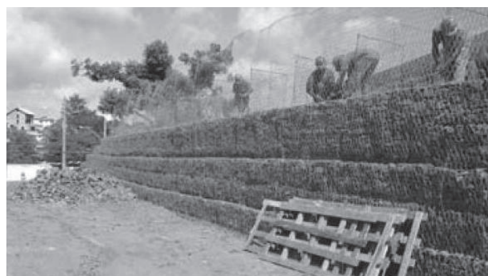
Figura 3.1.74 - Durante de la construcción
