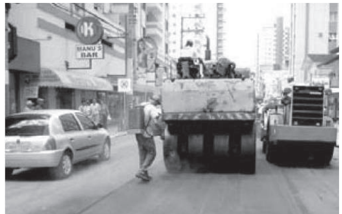
Figura 1.3.10 - Durante la obra
