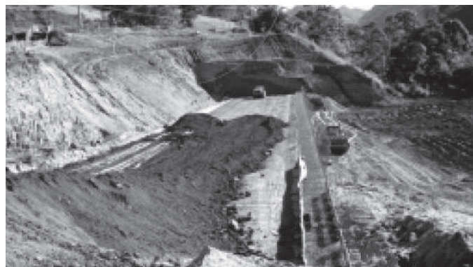
Figura 3.1.57 - Durante la construcción
