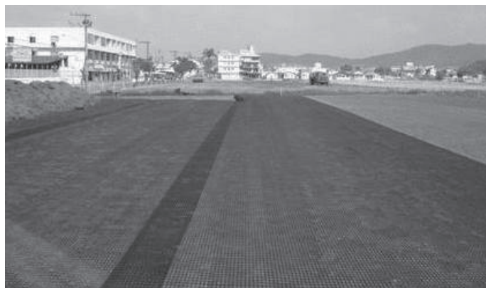
Figura 1.2.6 - Durante la obra
