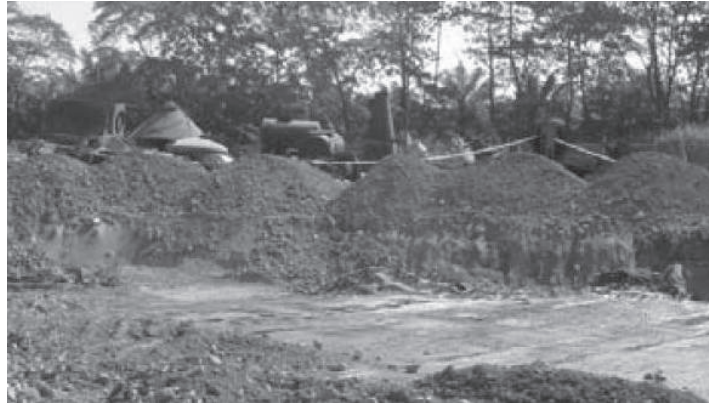
Figura 2.2.13 Superficie limpia y regularizada para recibir los refuerzos geosintéticos.
