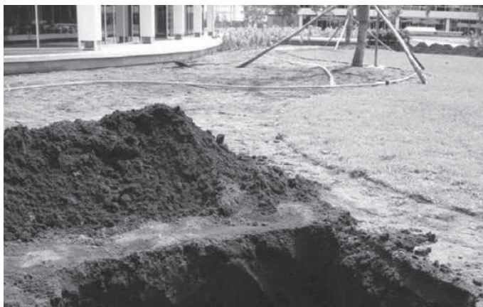
Figura 2.1.21 - Durante la obra
