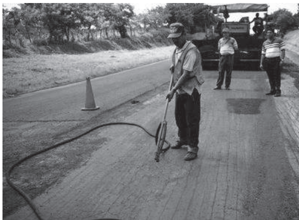
Figura 1.3.13 - Preparación y limpieza del área para posterior aplicación de ligante asfáltico
