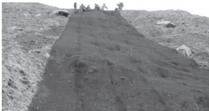
Figura 5.1.16 - Durante la construcción
