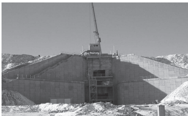
Figura 3.1.10 – Tomadas de la aplicación en contención de la solución MacForce®.
