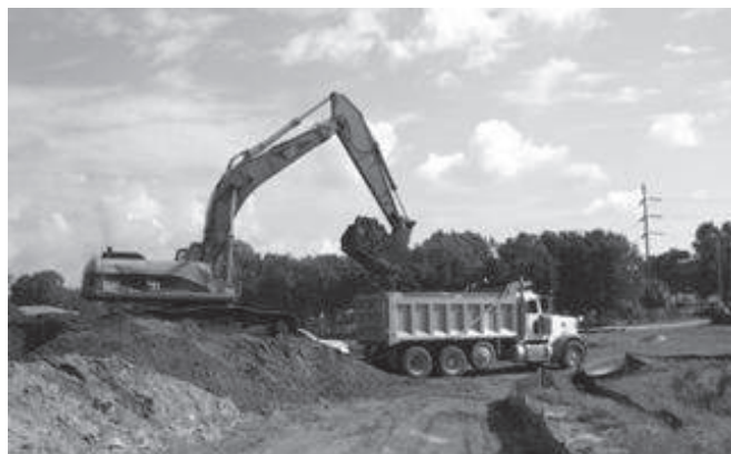
Figura 4.4.5 - Durante la obra
