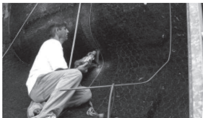
Figura 5.1.8 - Durante la construcción
