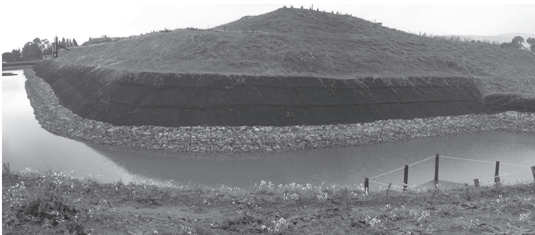
Figura 5.1.42 - "Ecolândia" - Fotografía prontamente después de la instalación
