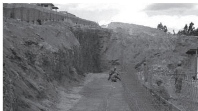
Figura 3.1.73 - Durante la construcción
