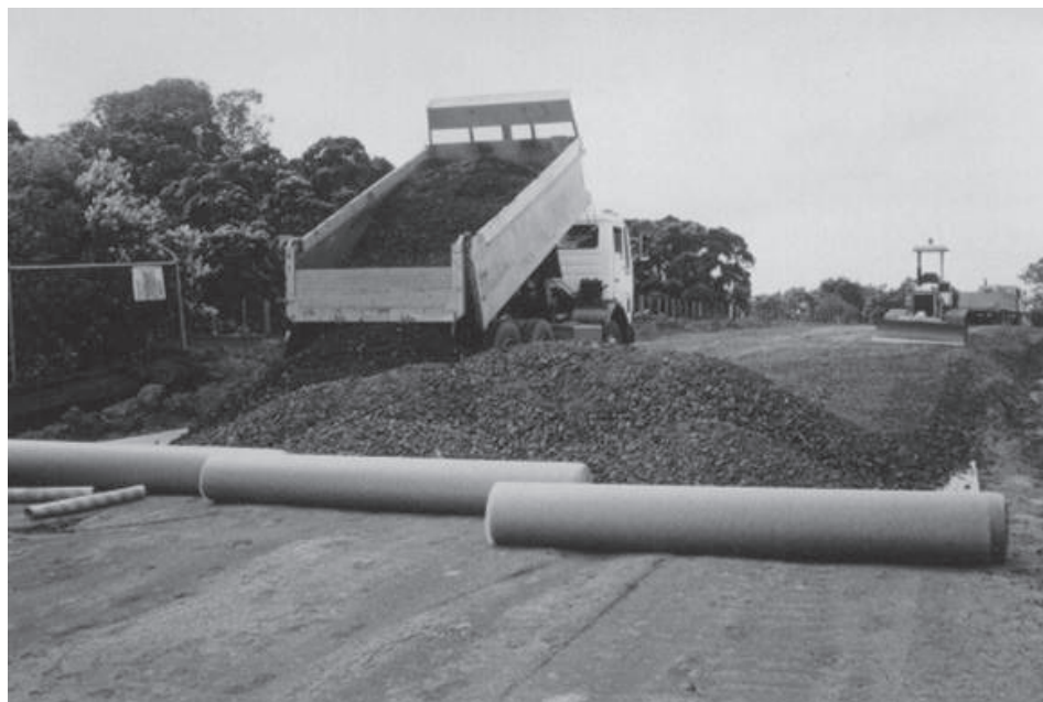
Figura 1.1.15 - Aplicación y regularización de material de cobertura.
