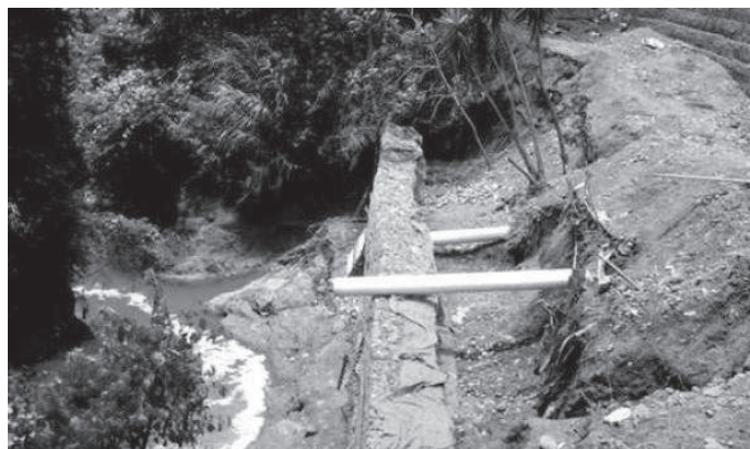
Figura 3.1.66 - Durante la construcción
