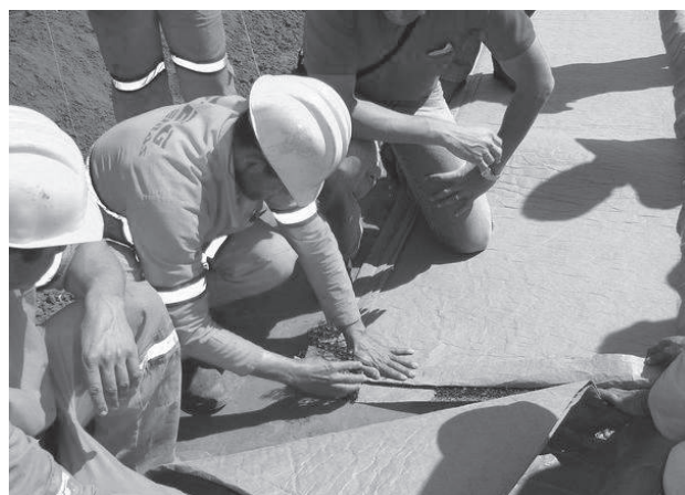
Figura 1.4.15 - Realización de unión entre fin y comienzo de rollos de geocompuesto drenante.
