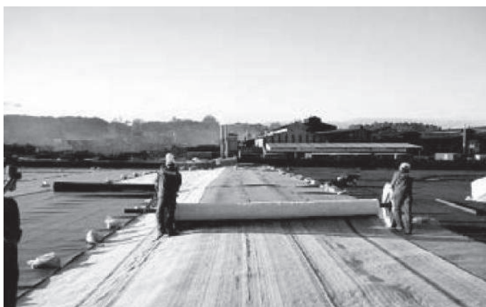
Figura 4.2.13 - Durante la obra
