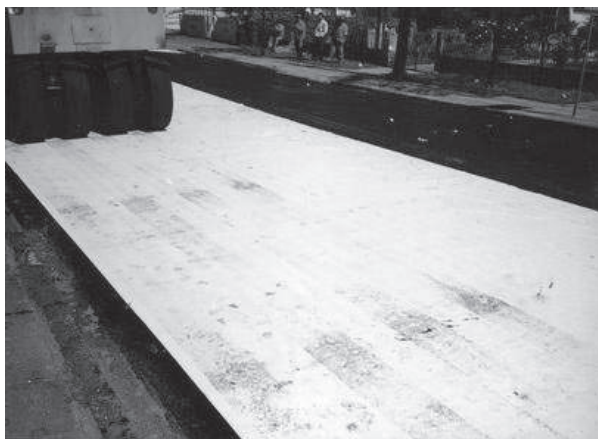
Figura 1.3.15 - Compactación del geotextil aplicado sobre emulsión.
