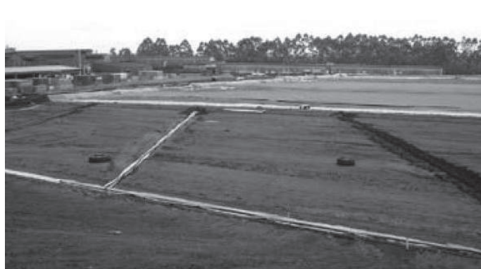
Figura 4.2.10 - Durante la obra
