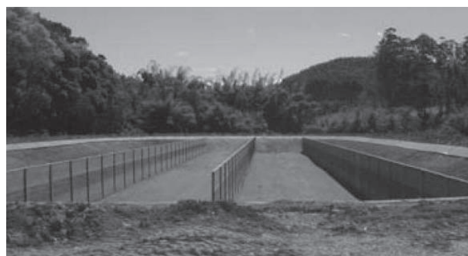
Figura 4.3.3 - Durante la obra
