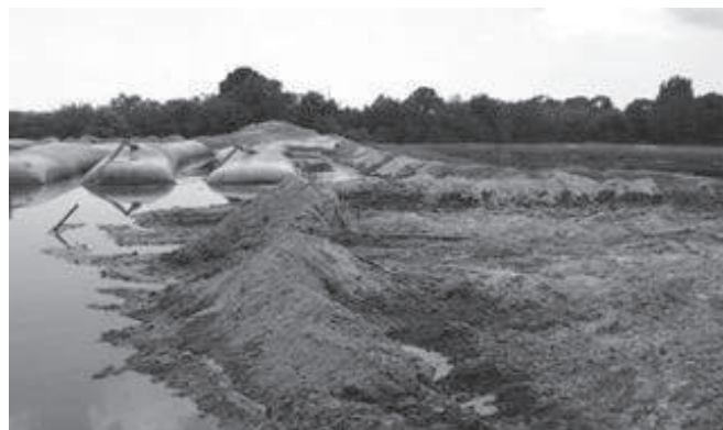
Figura 4.4.4 - Durante la obra
