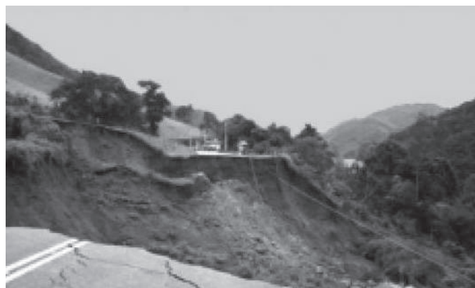
Figura 3.1.56 - Antes de la obra
