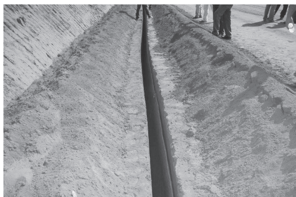
Figura 1.4.16 - Geocompuesto drenante inserto en la trinchera excavada.
