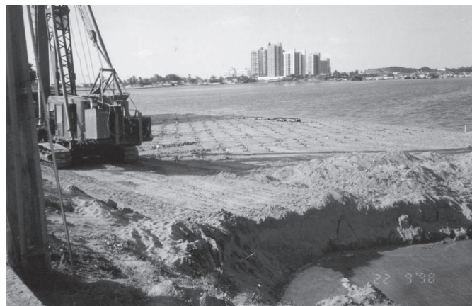
Figura 3.2.6 - Durante la obra
