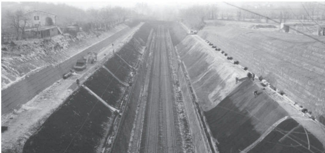
Figura 5.1.40 - Verona - Obra prontamente después de la instalación.
