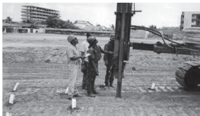
Figura 3.2.7 - Durante la obra
