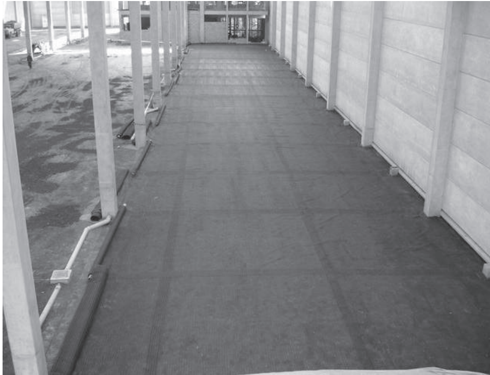
Figura 1.2.15 - Geogrilla aplicada sobre la superficie regularizada.
