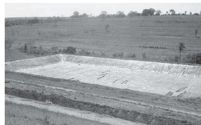
Figura 4.1.14 - Durante la obra
