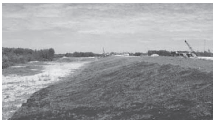
Figura 5.1.25 - Durante la construcción
