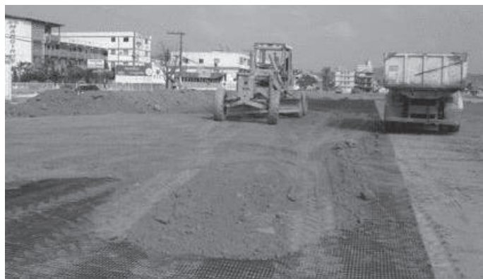
Figura 1.2.7 - Durante la obra
