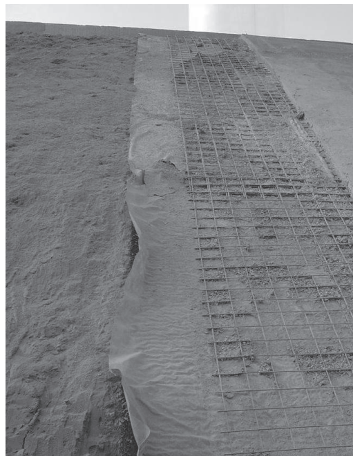
Figura 2.1.2 – Sistema de drenaje inclinado con uso del geocompuesto MacDrain® FP. a) MacDrain® FP colocado sobre el talud con la malla electrosoldada sobre él, esperando el concretaje. b) Concretaje directamente sobre el MacDrain® FP.
