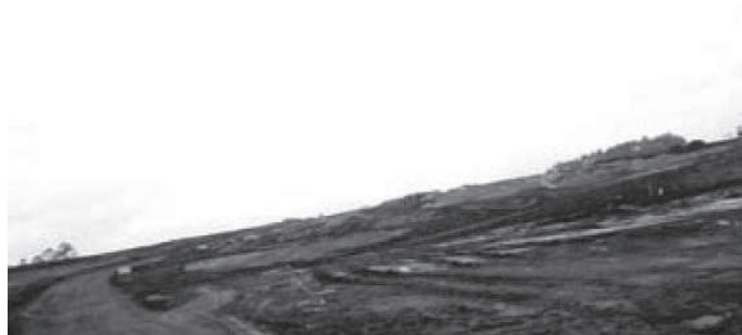
Figura 4.2.9 - Durante la obra
