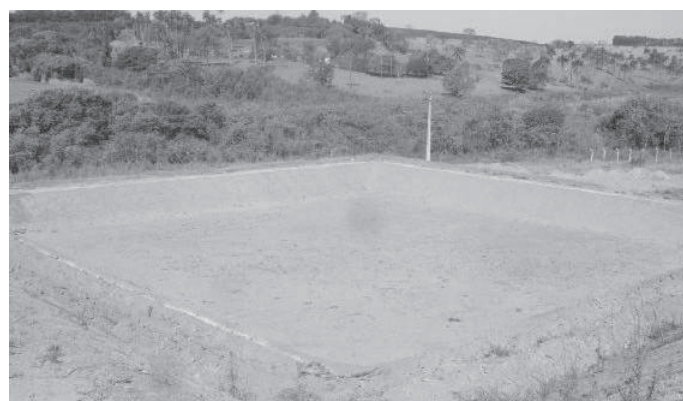
Figura 4.1.9 - Durante la obra
