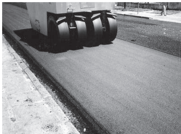
Figura 1.3.16 - Compactación del concreto asfáltico.
