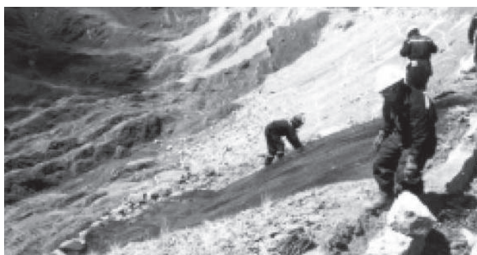
Figura 5.1.17 - Durante la construcción
