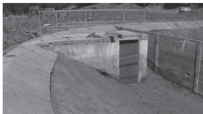
Figura 4.3.5 - Durante la obra
