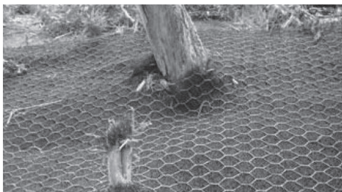
Figura 5.1.33 - Durante la construcción
