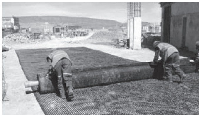
Figura 3.1.82 - Durante la obra
