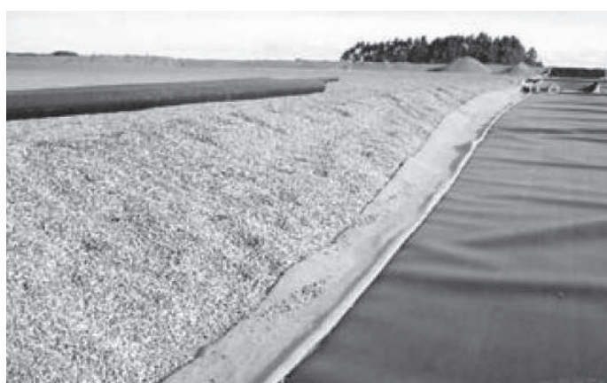
Figura 4.2.14 - Durante la obra
