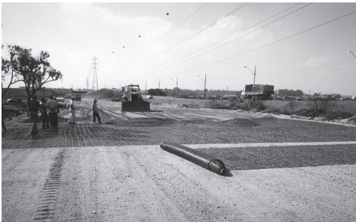
Figura 3.2.12 Aplicación de geogrilla en superficie regularizada.
