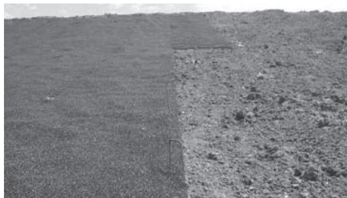
Figura 5.1.24 - Durante la construcción
