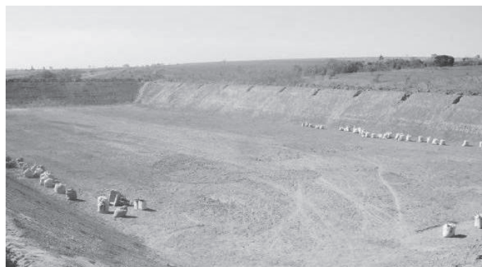
Figura 4.1.7 - Durante la obra
