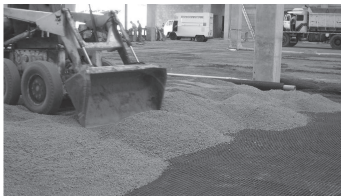
Figura 1.2.8 - Durante la obra
