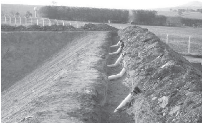
Figura 4.1.11 - Durante la obra
