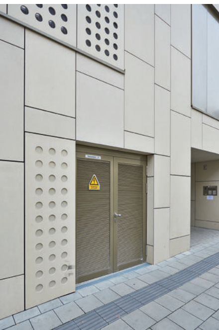
Außentür mit Lüftungslamellen.
