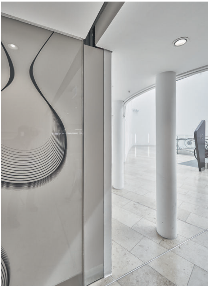
Das Feuerschutz-Schiebetor verbirgt sich hinter einer Nischenklappe.
