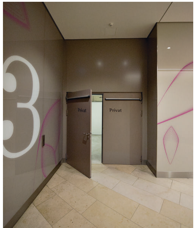
Doppelflügelige Brand- und Rauchschutztür im Minto.
