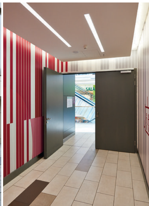
Zweiflügelige Feuer- und Rauchschutztüren schützen die Fluchtwege in den Außenbereich.
