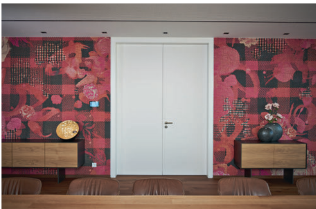
Brand- und Schallschutztür mit Holzfutterzarge ohne Zierfalz.
