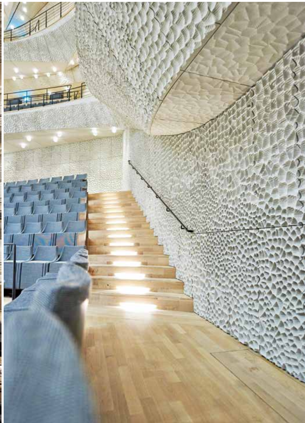
Akustisch wirksam: die „Weiße Haut“ des Großen Saals, gefertigt aus speziell gefrästen Gipsplatten.
