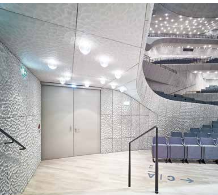
Doppelflügelige Brand- und Rauchschutztüren im Großen Saal.
