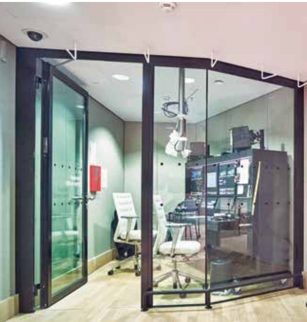
Rohrrahmenelemente begrenzen den Regieraum.
