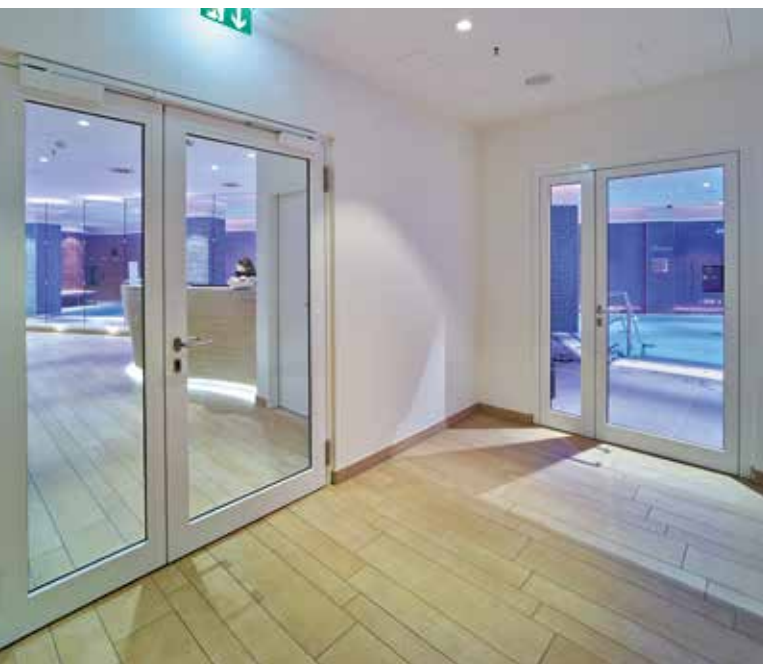
Vollverglaste Rohrrahmenelemente gewähren Einblicke ins Spa des Hotels.
