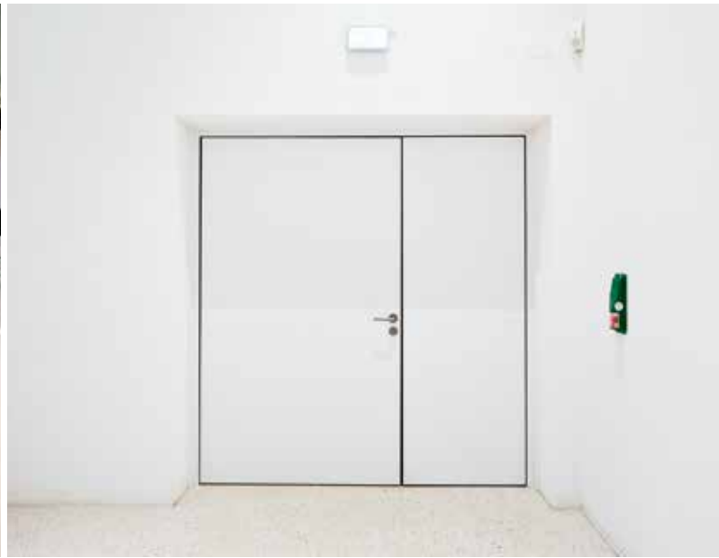
Bei Bedarf kann der Standflügel geöffnet und der Durchgang erweitert werden.
