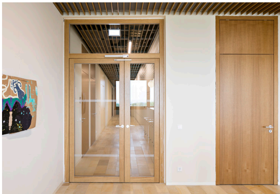
Bei Bedarf kann die Durchgangsbreite der Brand- und Rauchschutztür erweitert werden.
