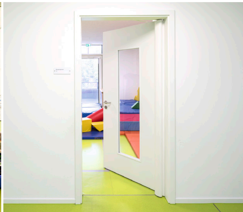
Um die Fingerschutzrollos so dezent wie möglich zu halten, sind sie in Weiß ausgeführt. Ein Lichtausschnitt offenbart den Kindern, wer sich hinter der Tür verbirgt.
