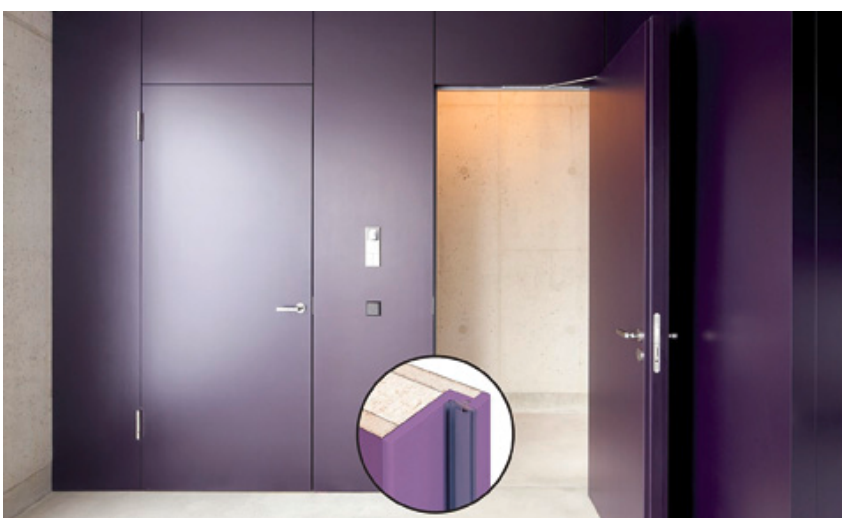
Die angegossene PU-Kante schützt gegen mechanische Einwirkungen.
