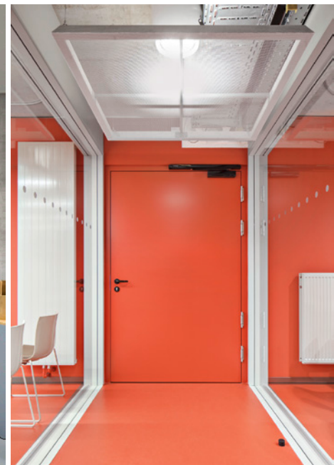
Durch die schmalen Friesbreiten gelangt über großzügige Glasausschnitte Licht ins Innere der Besprechungsräume. Farblich perfekt integrierte Tür.
