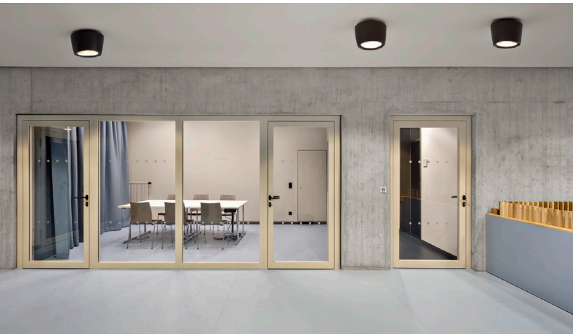
Durch die schmalen Friesbreiten gelangt über großzügige Glasausschnitte Licht ins Innere der Besprechungsräume. Farblich perfekt integrierte Tür.
