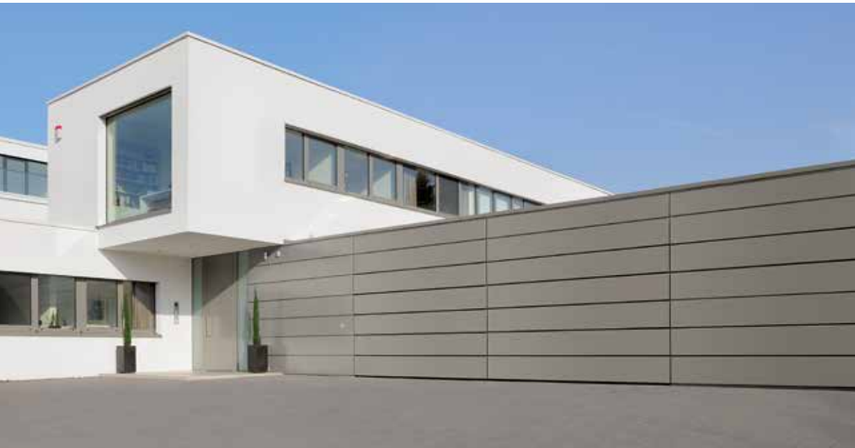
Oblaganje na mestu vgradnje z aluminijastimi vezanimi ploščami
