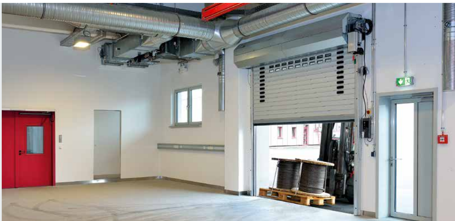
Visoka hitrost odpiranja in zapiranja do 1,1 m/s optimira obratovalne procese in zmanjša toplotne izgube.
