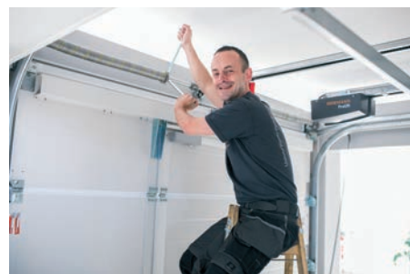
SEKCIJSKA GARAŽNA VRATA NAPENJANJE VZMETI
