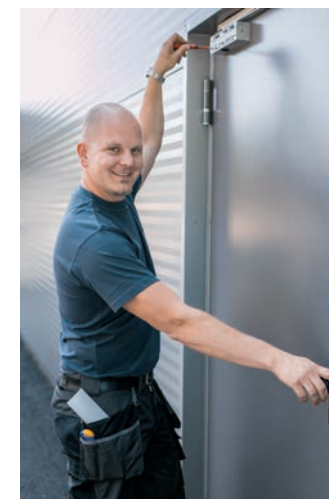
KRILNA POŽARNA VRATA KONTROLA REGULATORJA ZAPIRANJA
