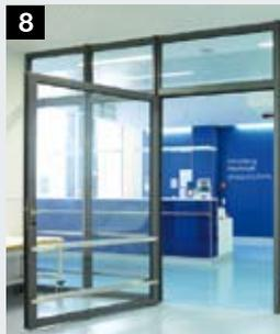
8 Ognjevorni in dimotesni elementi z okvirji iz cevnih profilov
