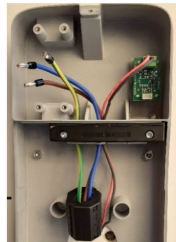
Installazione ferrite con cavi di connessione della scheda con optoMOS (optoisolatore)
