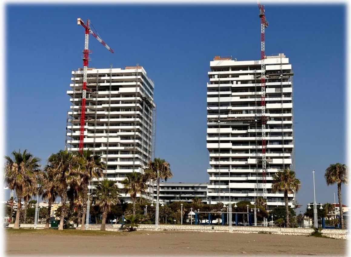
Torre Living (Málaga)
