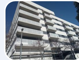
Edifici Barberá (Barcelona)
