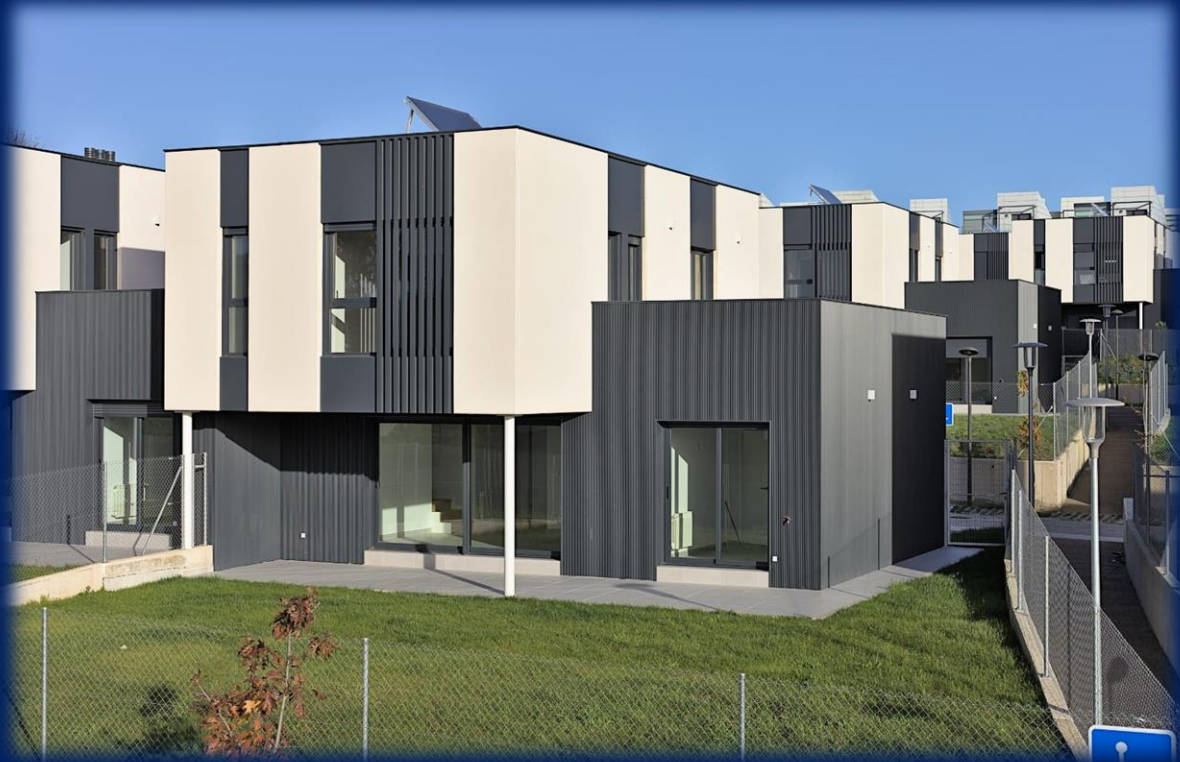
Residencial San Marcos (Santiago de Compostela – A Coruña)
