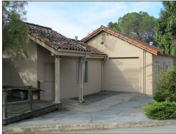
EXISTING FOLGER PUMP STATION
