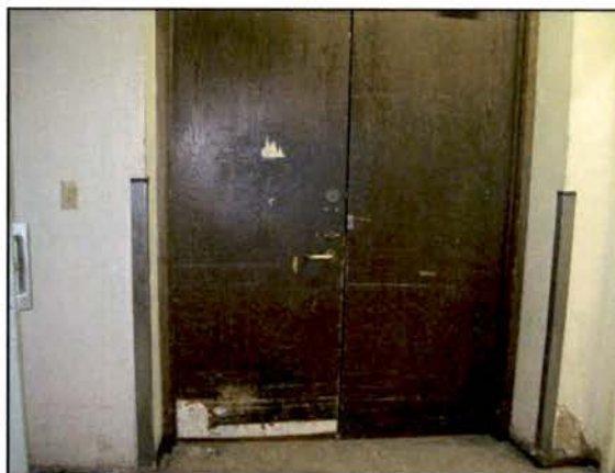
Fire Door Insulation (Sample 16A)
