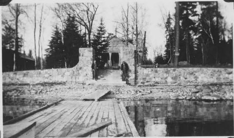
STONE WALL - KABETOGAMA R. STATION.
