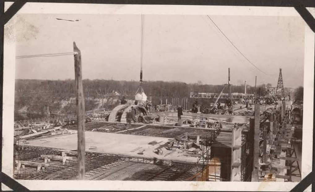
Pouring Slab . Span 10 . Oct. 26, 1926.
