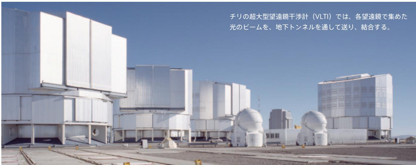
チリの超大型望遠鏡干渉計 (VLTI) では、各望遠鏡で集めた光のビームを、地下トンネルを通して送り、結合する。
