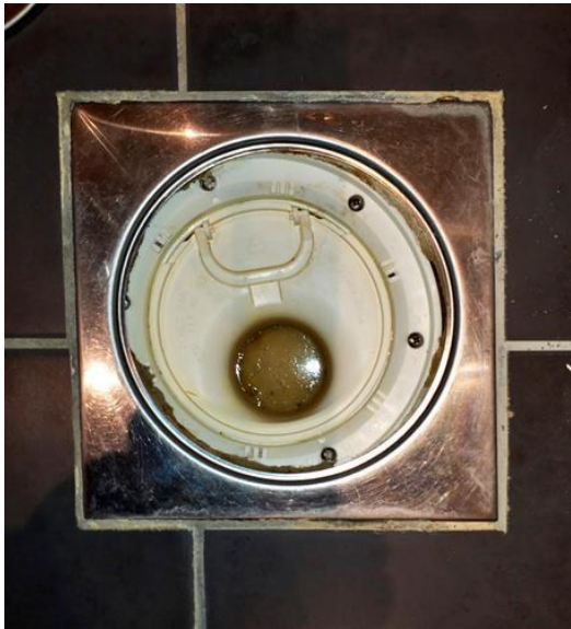
Våtrom - [Sluk bad]
