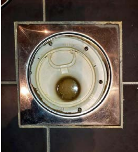
Våtrom - [Sluk bad]
