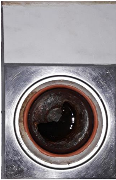
Våtrom - [Sluk bad]
