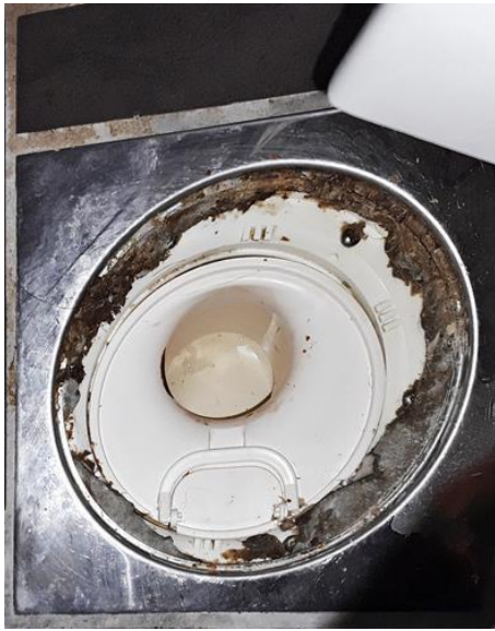
Våtrom - [Sluk bad]
