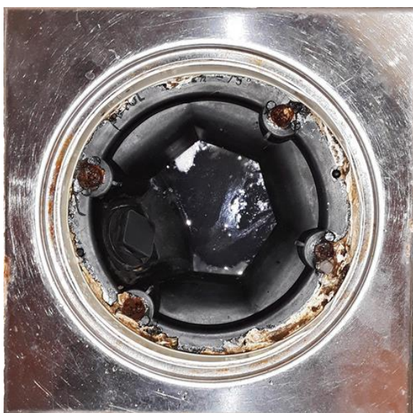
Våtrom - [Sluk bad 1. etasje]
