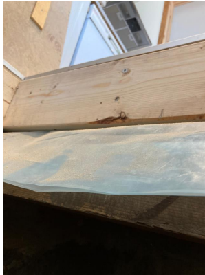
Plast i etasjeskiller mot krypkjeller.
