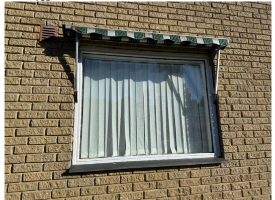
Vinduer fra byggeår.
