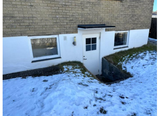
Vinduer fra byggeår.
