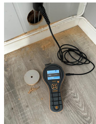
Hulltaging og fuktmåling i vegg.
