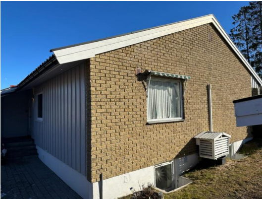
Gavlvegger i teglstein.
