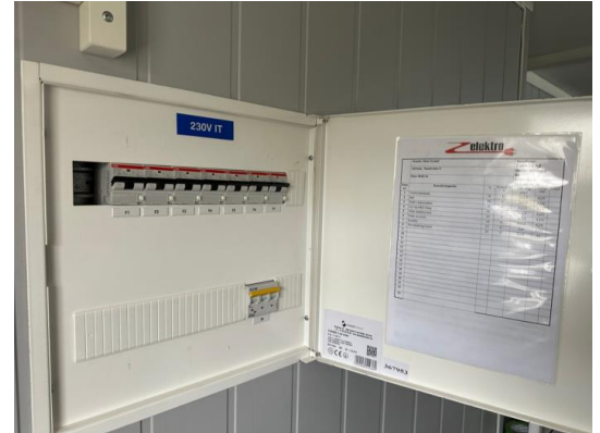
Skap i underetasje.
