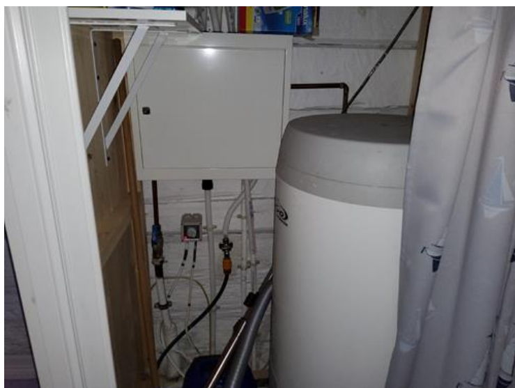
Tekniske anlegg, VVS anlegg (Sjekkpunkter utover det som er inkludert i andre rom) - [Tekniske installasjoner.]
