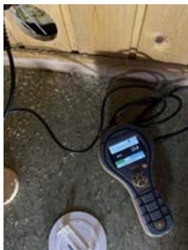
Hulltaking og fuktmåling i vegg.
