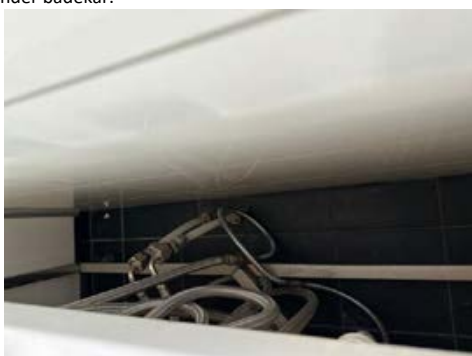
Rørgjennomføringer i gulv.
