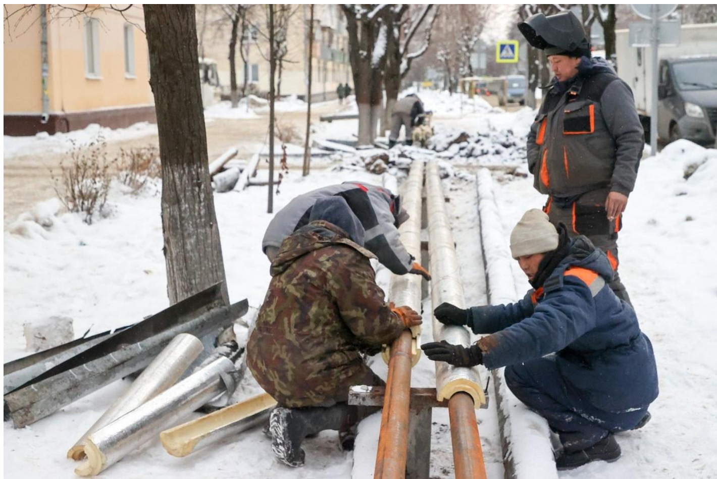
Аварийная ремонтная бригада во время прокладки временного водопровода в Подольске после прорыва теплотрассы. Фото: Сергей Петров / NEWS.ru / ТАСС
