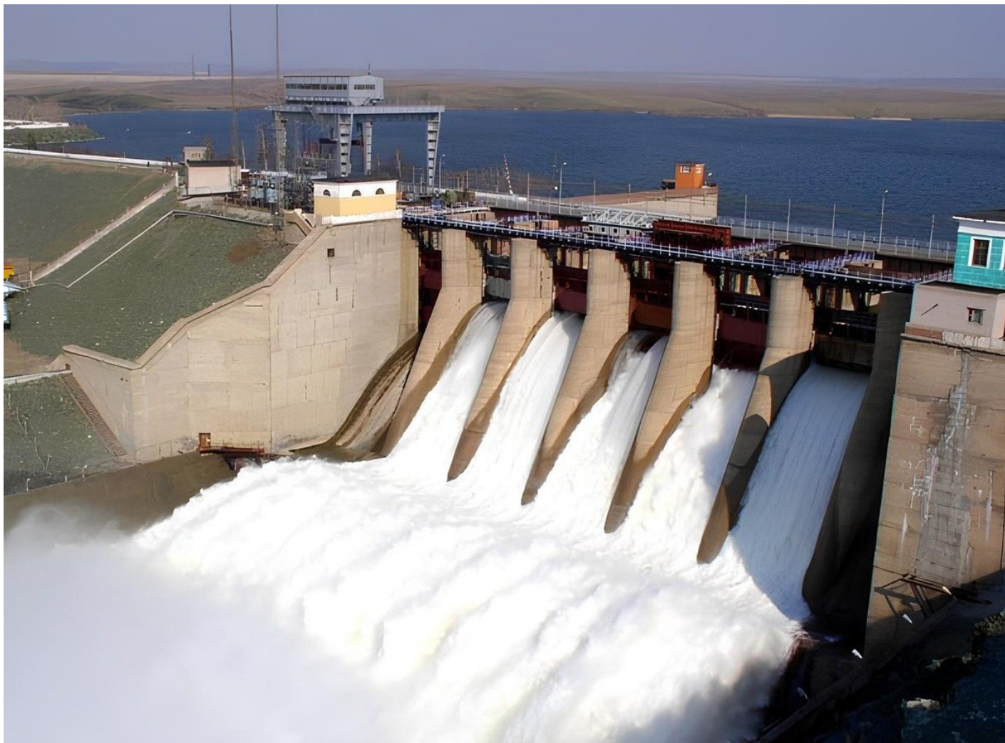
Комплекс гидросооружений Ириклинского водохранилища. Фото: Википедия
