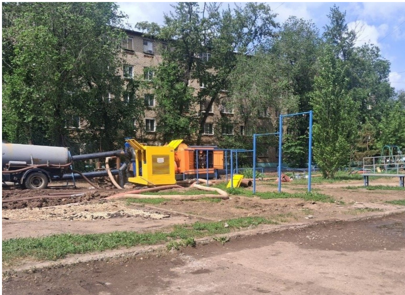
Работы недалеко от аварийного коллектора. Энгельс. Фото автора
