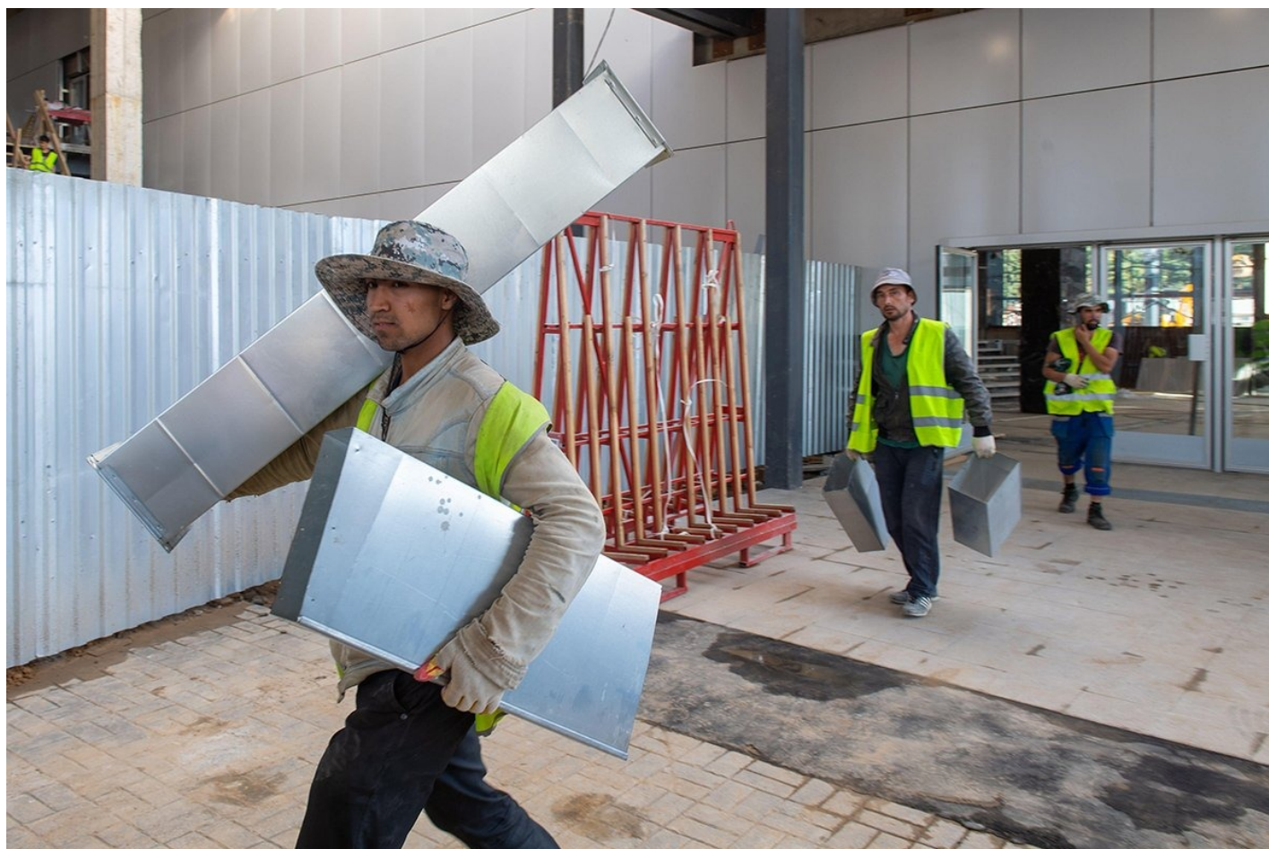
Рабочие на станции «Крюково» третьего Московского центрального диаметра (МЦД-3) в Зеленограде, 15 августа 2023 года. Фото: Picvario Media, LLC / Alamy / Vida Press
