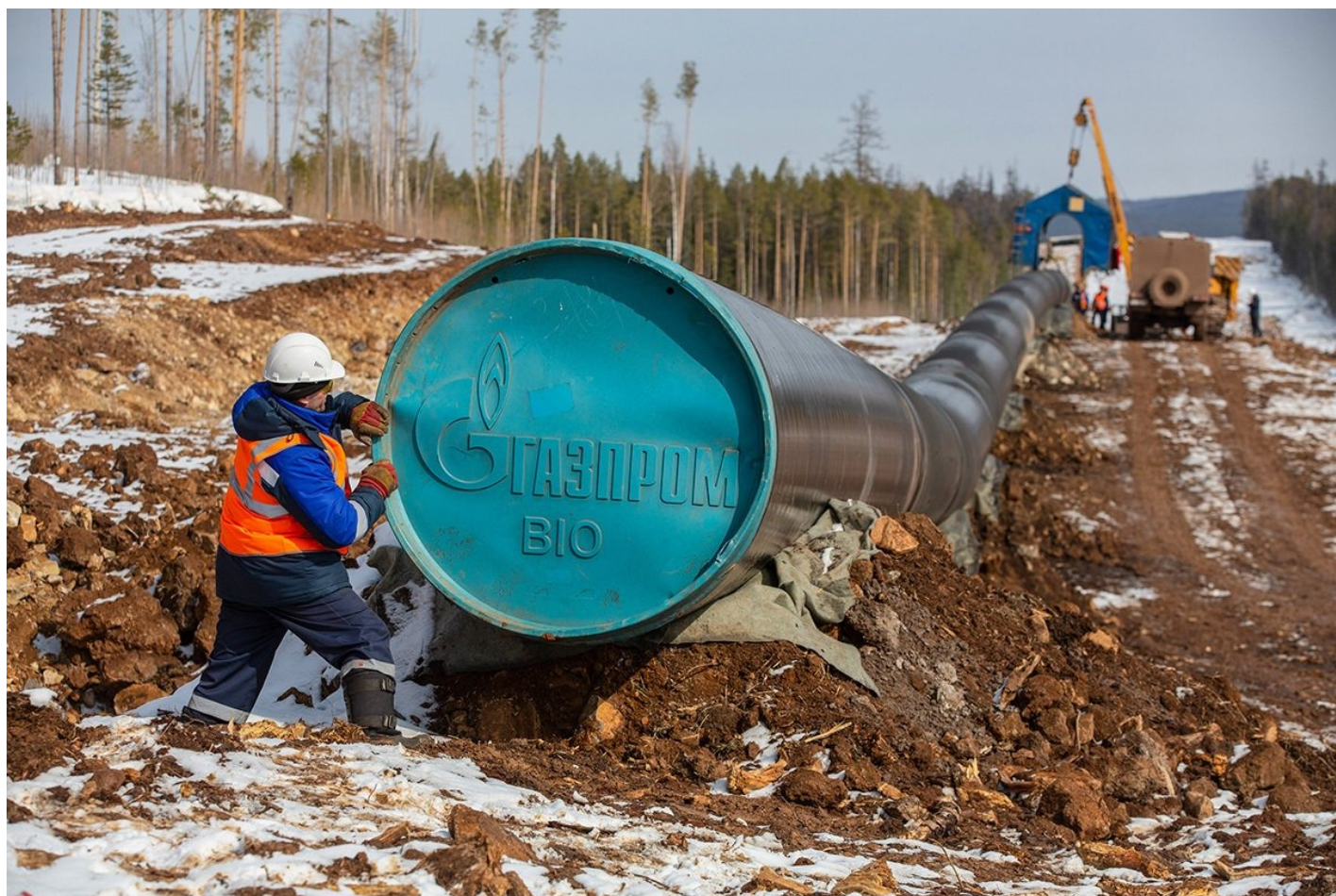
Рабочий устанавливает заглушку с логотипом «Газпром» во время работ по укладке газопровода «Сила Сибири» недалеко от Иркутска, 6 апреля 2021 года. Фото: Андрей Рудаков / Bloomberg / Getty Images
