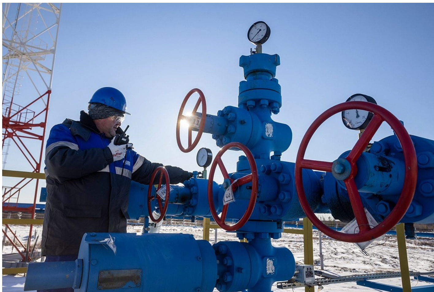
Рабочий поворачивает вентильное колесо на газовой скважине на Чаяндинском нефтегазоконденсатном месторождении ПАО «Газпром» — ресурсной базе газопровода «Сила Сибири» — в Республике Саха, 12 октября 2021 года. Фото: Андрей Рудаков / Bloomberg / Getty Images
