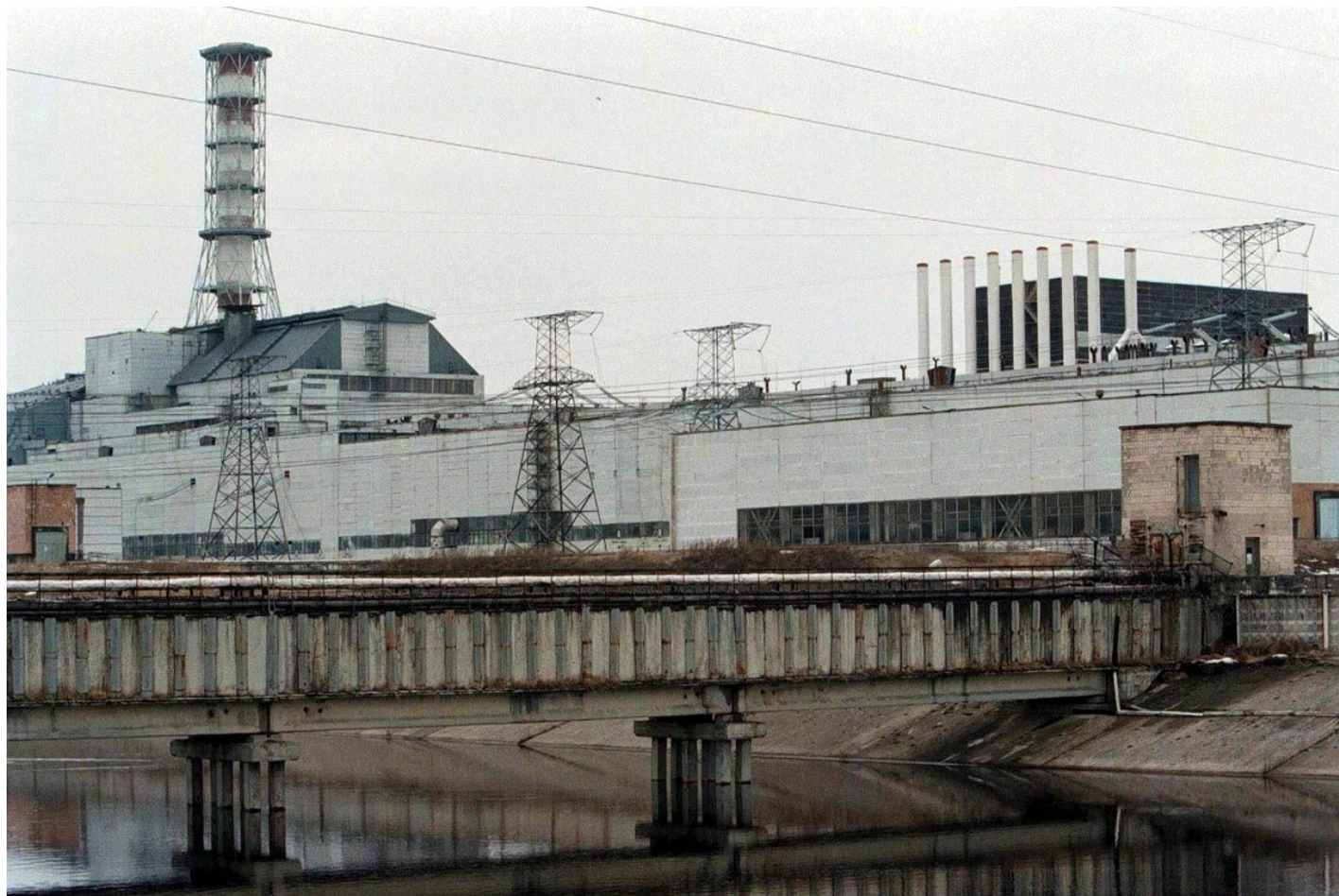
Третий энергоблок (справа) и четвертый энергоблок под «саркофагом» (слева) Чернобыльской атомной электростанции, 4 марта 1999 года. Фото: Сергей Супинский / ЕРА
