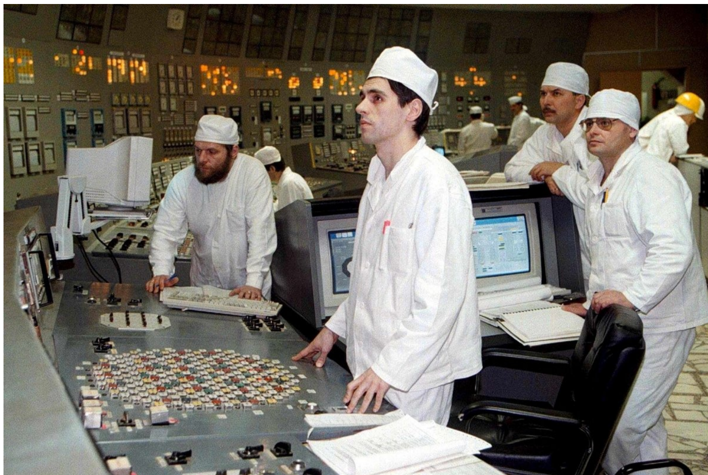
Оператор осматривает панель управления третьего энергоблока Чернобыльской АЭС, 4 марта 1999 года. Третий энергоблок мощностью один миллион киловатт, единственный работающий блок станции, был остановлен 12 декабря 1998 года для проведения плановых ремонтных работ и был снова запущен 6 марта 1999 года. Фото: Сергей Супинский / EPA
