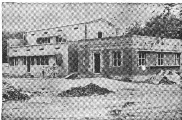
Hier ziet U een foto van het weeshuis, toen het nog in aanbouw was.
