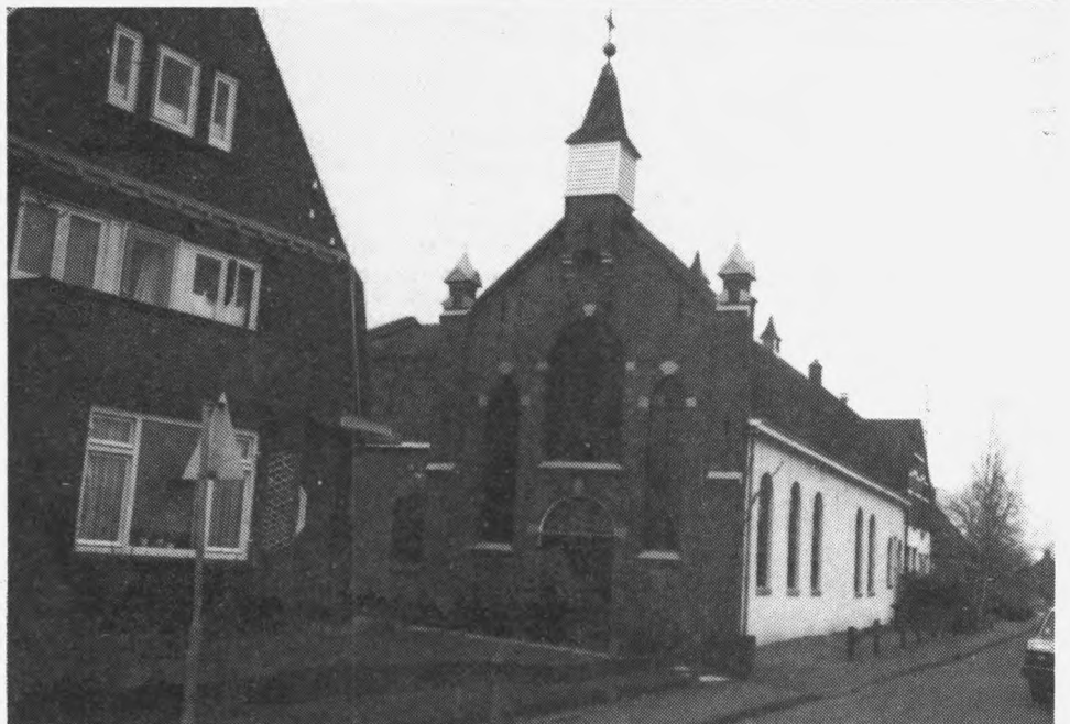
Het kerkgebouw van de Nederlands Gereformeerde kerk in Zalk is nog het gebouw van de vroegere afgescheiden gemeente; het dateert uit ongeveer 1860. Later werd het uitgebreid. In 1905 werd er dwars op het oorspronkelijke gebouw een dwarsvleugel gezet, waarbij de preekstoel verplaatst werd. Op de voorgrond de pastorie, die later gebouwd werd (uit 1926).
