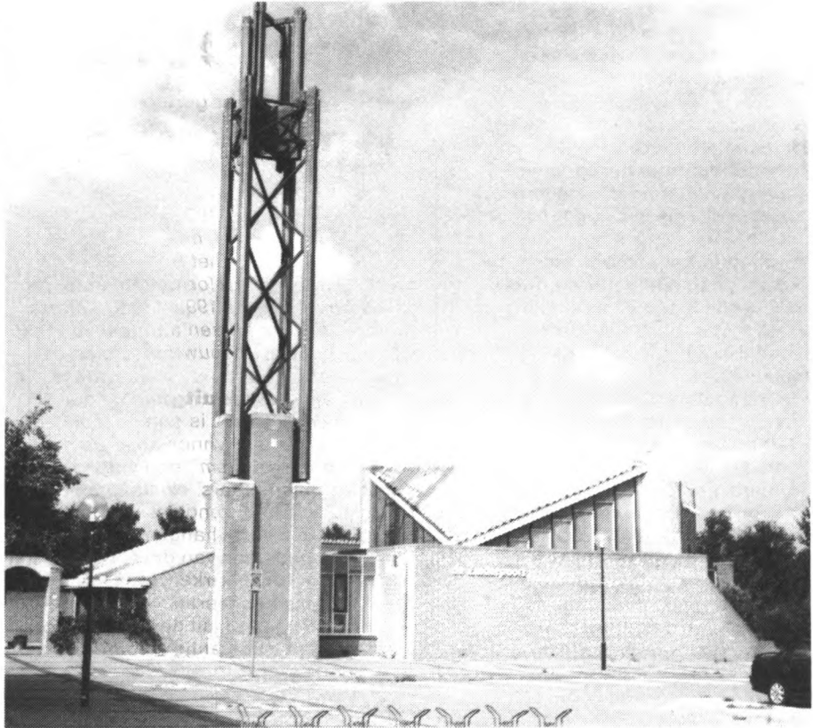
Het kerkgebouw van de (volledig samenwerkende) Nederlands Gereformeerde en Christelijke Gereformeerde Kerk in Almere: de Zuiderpoort.
