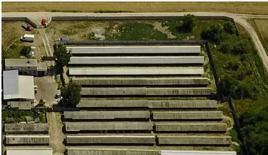
Ferma w Chodzieży (woj. wielkopolskie) - podwójne betonowe ogrodzenie
