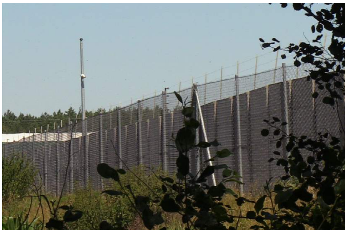
Ferma w Czarnej Wsi (woj. wielkopolskie), - podwójne ogrodzenie z siatki prawidłowo wkopanej w ziemię oraz jednolite betonowe.
