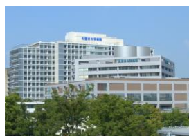
大学病院本館と総合診療棟
