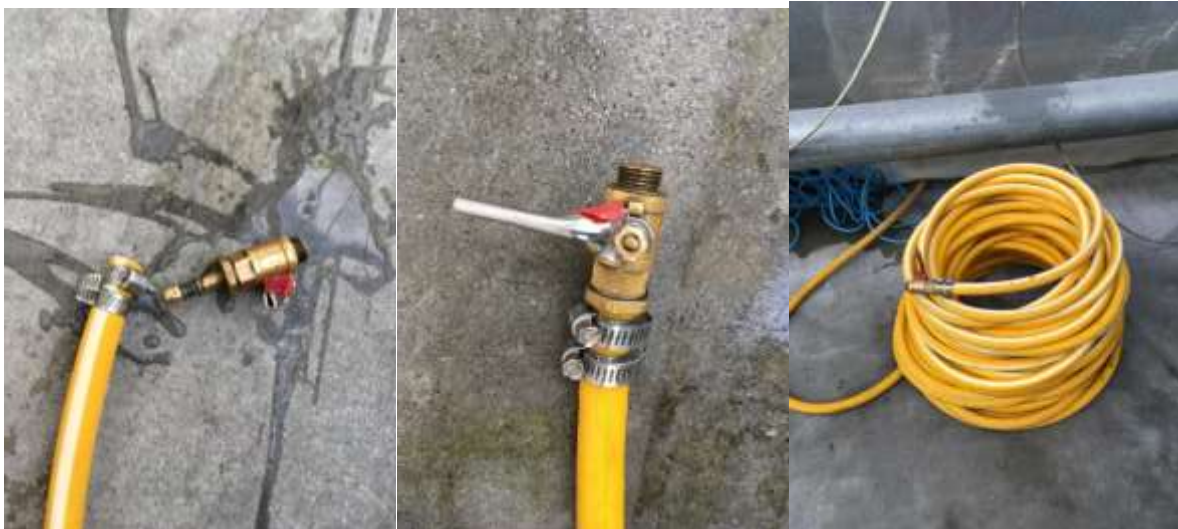
↑(左:接続部崩壊/真中:修理済/右:k 綺麗な8の字巻)
