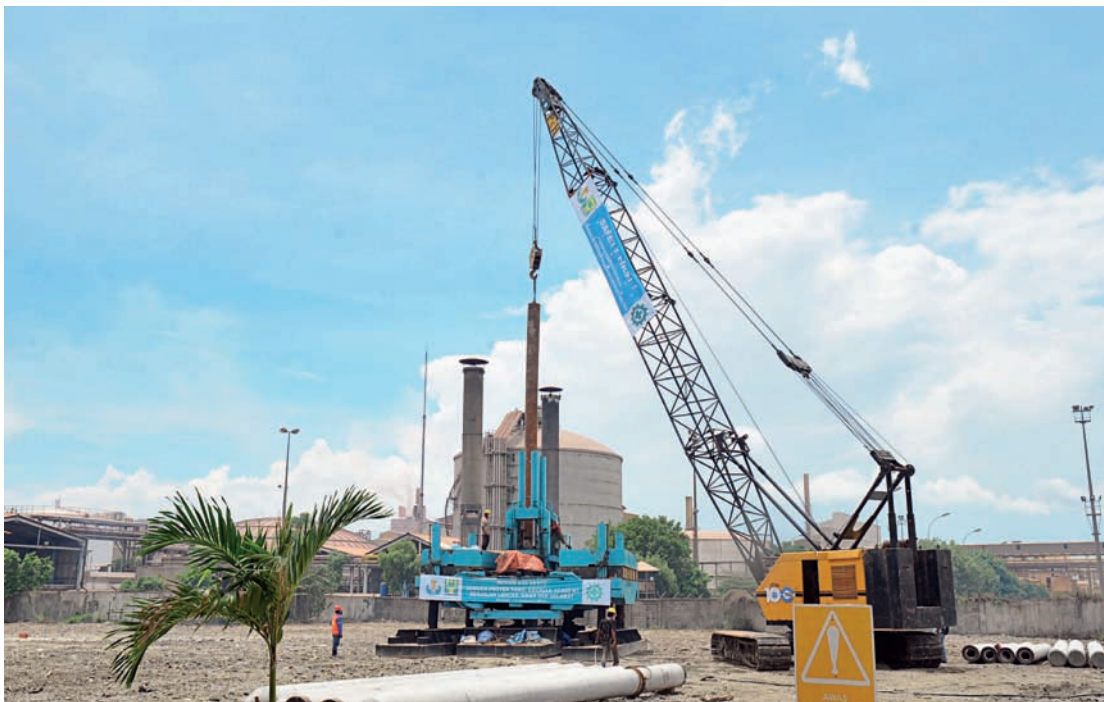
Pemancangan Tiang Pancang Pertama Pembangunan Tanki Amoniak
