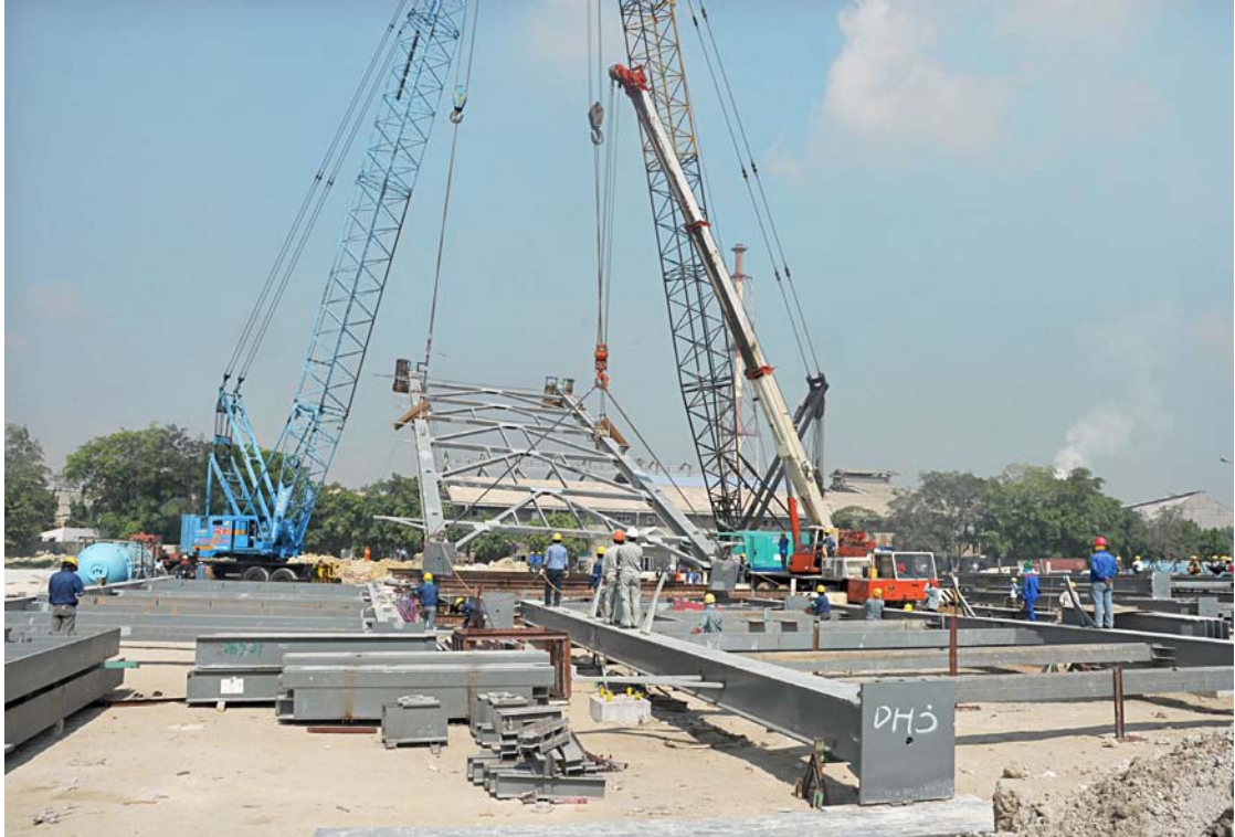
Aktivitas di Proyek Konversi Energi Batubara
