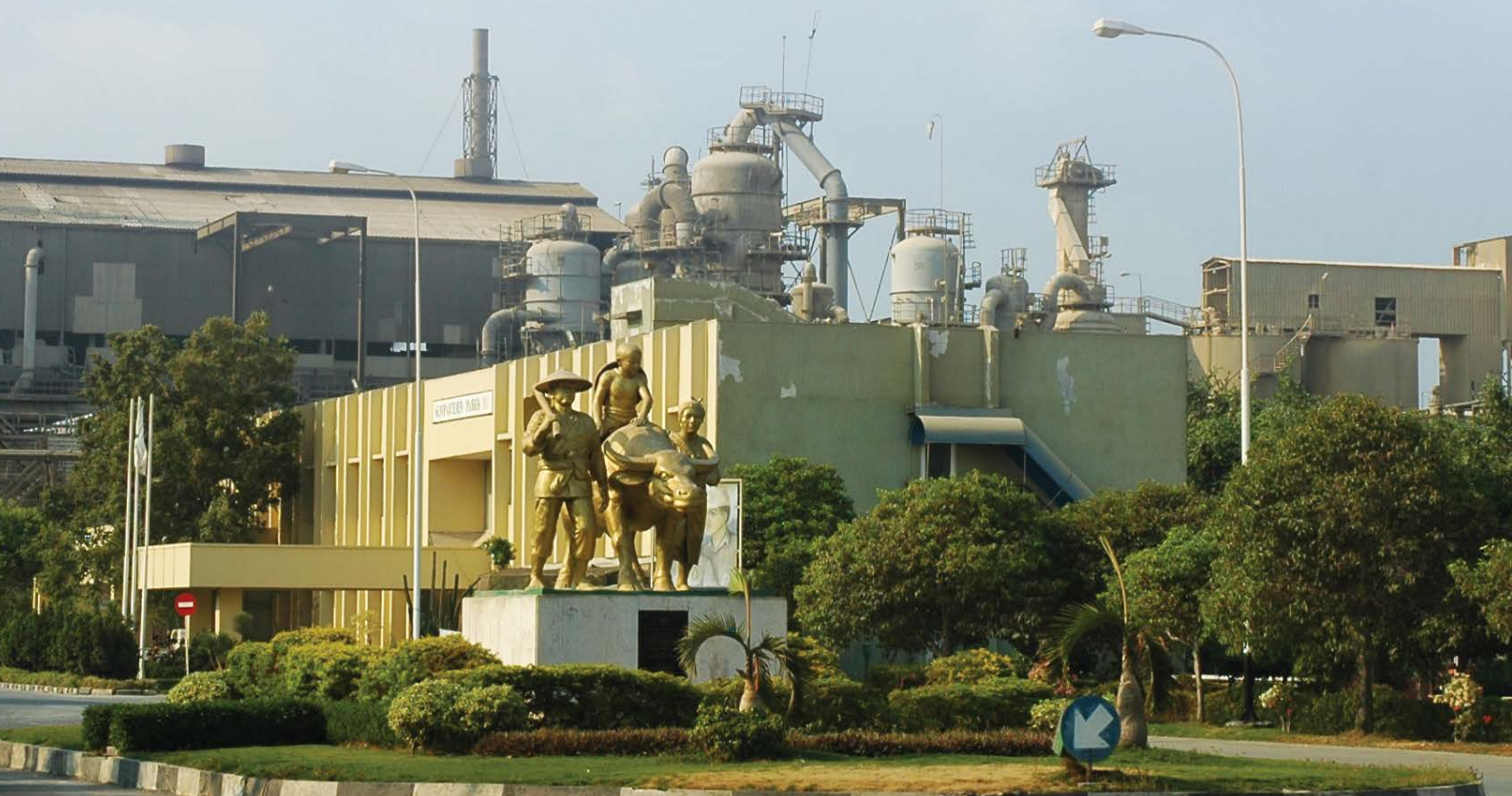
Patung Tri Dharma PT Petrokimia Gresik yang juga sebagai pintu gerbang Kompleks Pabrik III The statue of Tri Dharma of PT Petrokimia Gresik functioning as the gateway of Plant III
