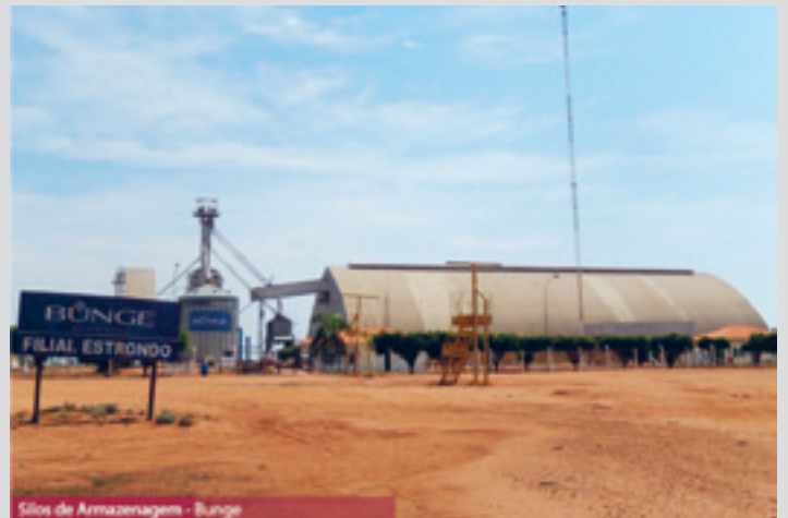
Silos de Armazenagem - Bunge
