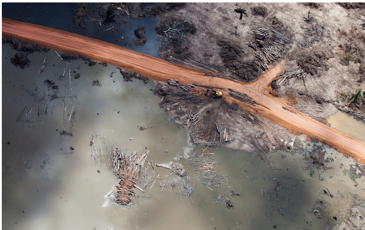
Vista aerea del cantiere della diga di Belo Monte sul Fiume Xingu, Stato del Pará © Daniel Beltrà/ Greenpeace.
