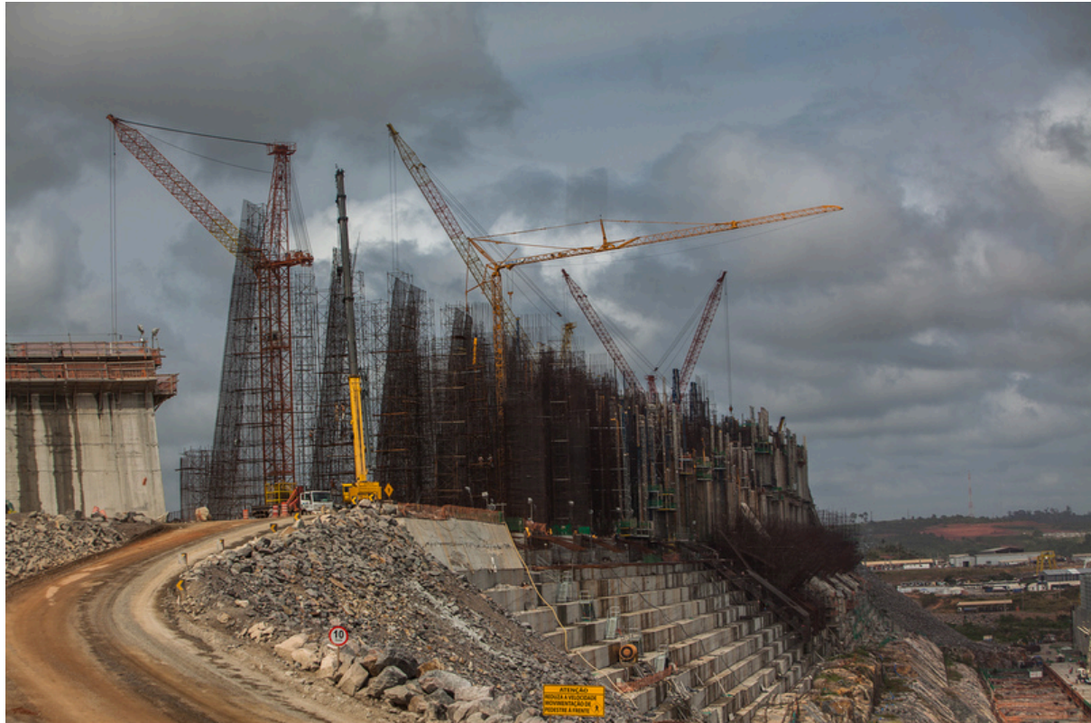
Costruzione della diga idroelettrica di Belo Monte sul Fiume Xingu, Stato del Parà © Daniel Beltra/Greenpeace.
