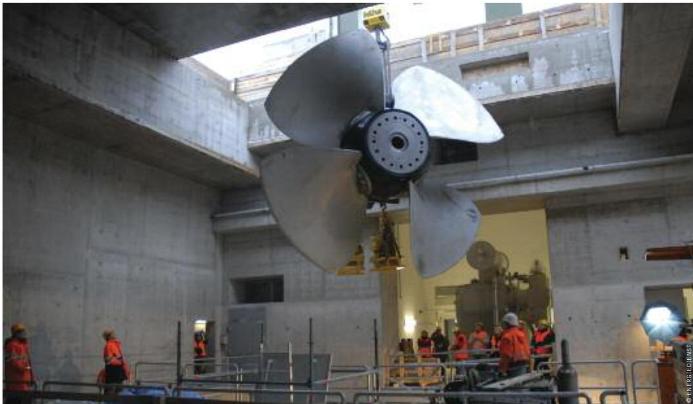
**bild** EINBAU EINES LAUFRADS IM FLUSSKRAFTWERK RHEINFELDEN, DAS SEIT 2010 STROM FÜR 42'000 HAUSHALTE LIEFERT, IM FLUSSKRAFTWERK RHEINFELDEN. INSGESAMT PRODUZIERT DAS KRAFTWERK STROM FÜR RUND 170 000 HAUSHALTE JÄHRLICH.
