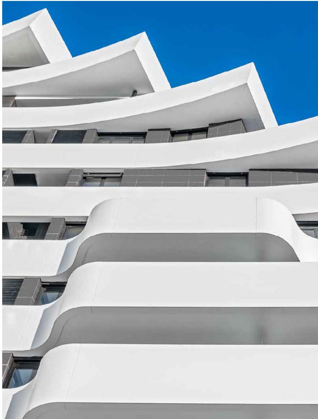
TERRAZAS DEL LAGO Détail de la façade. Plus de 5000 m 2 construits avec Krion® Solid Surface , en combinaison avec le système d'ancrage invisible de Butech . Ce projet a remporté le prix du meilleur projet réalisé lors de la XI e édition des Prix PORCELANOSA d'architecture et de décoration d'intérieur. Photo : Luzestudio Fotografía.
